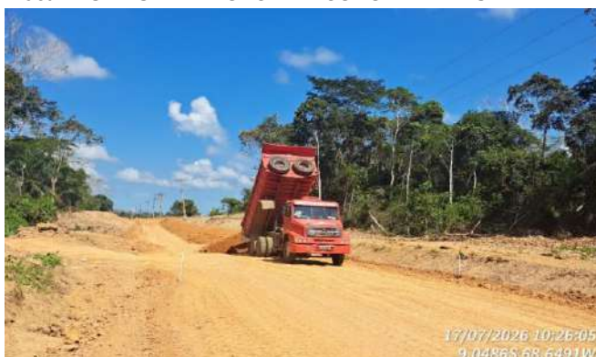
Imagem 105 TRANSPORTE DE MATERIAL PARA SUBBASE
