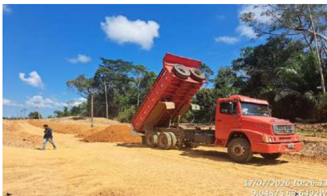
Imagem 107 TRANSPORTE DE MATERIAL PARA SUBBASE
