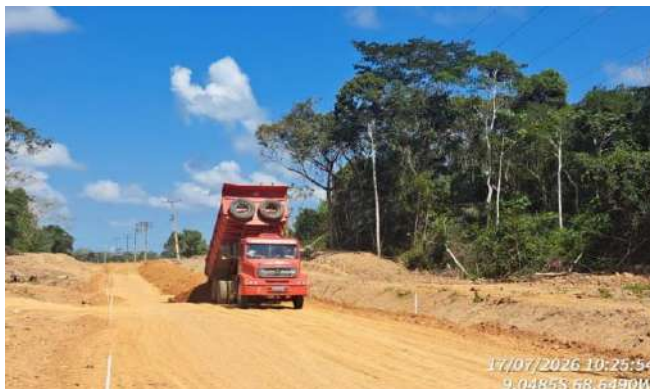
Imagem 104 TRANSPORTE DE MATERIAL PARA SUBBASE
