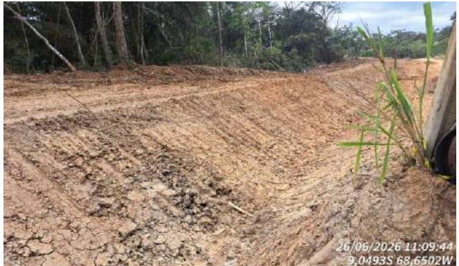
Imagem 44 ESCAVAÇÃO MECANIZADA
