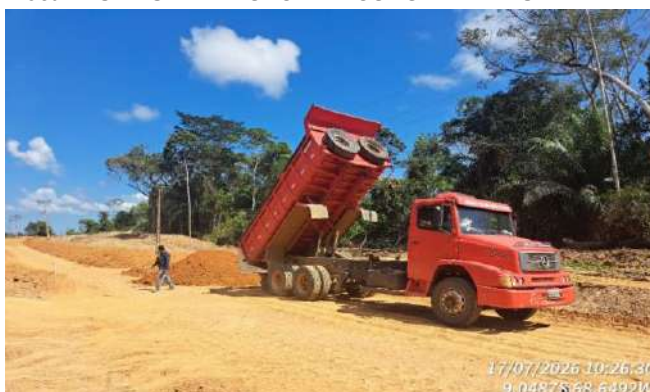
Imagem 106 TRANSPORTE DE MATERIAL PARA SUBBASE
