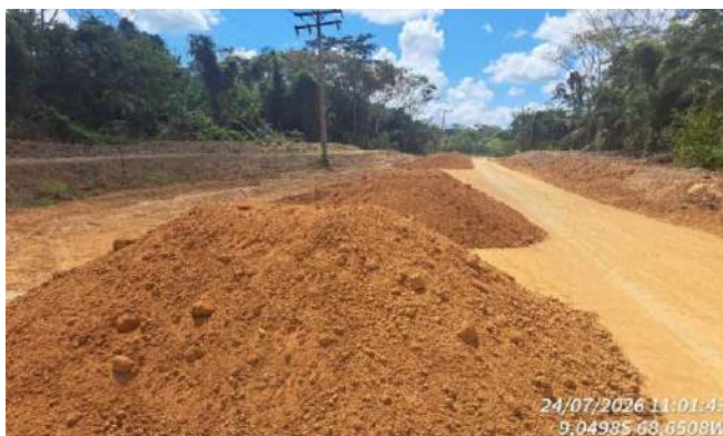
Imagem 108 MATERIAL PARA SUBBASE
