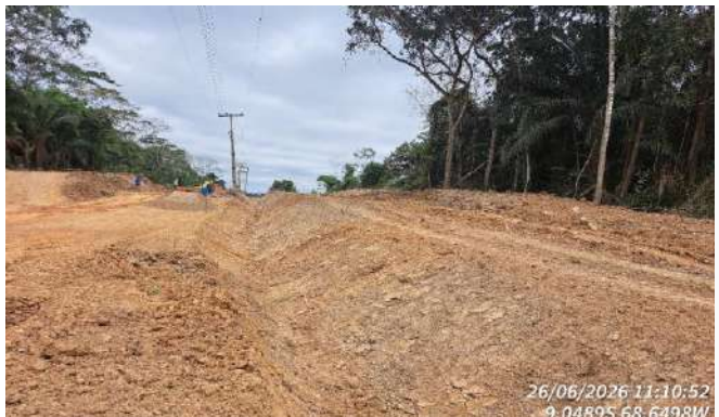
Imagem 46 ESCAVAÇÃO MECANIZADA
