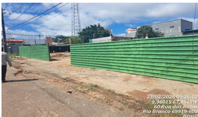
Imagem 9 EXECUÇÃO DE TAPUME
