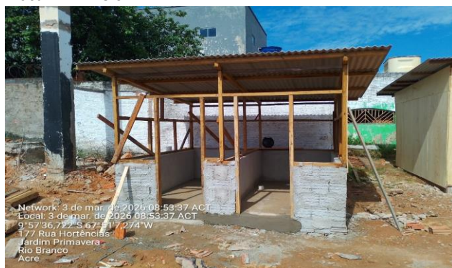
Imagem 15 EXECUÇÃO DE SANITÁRIO
