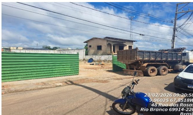
Imagem 8 EXECUÇÃO DE TAPUME
