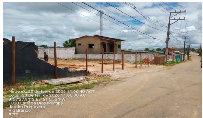
Imagem 6 EXECUÇÃO DE TAPUME
