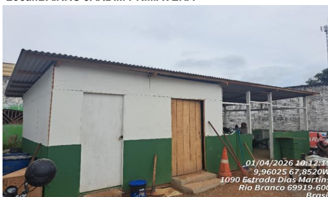
Imagem 18 SANITÁRIO, REFEITÓRIO, DEPÓSITO E VESTIÁRIO
