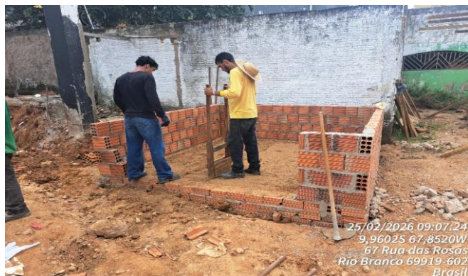
Imagem 13 EXECUÇÃO DE SANITÁRIO
