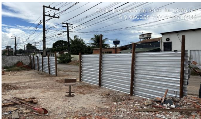
Imagem 7 EXECUÇÃO DE TAPUME
