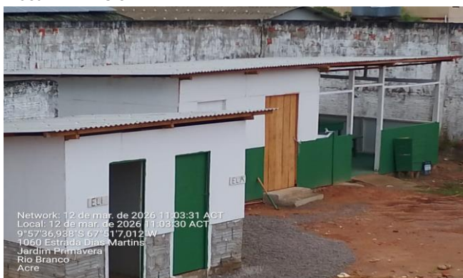
Imagem 16 SANITÁRIO, REFEITÓRIO, DEPÓSITO E VESTIÁRIO
