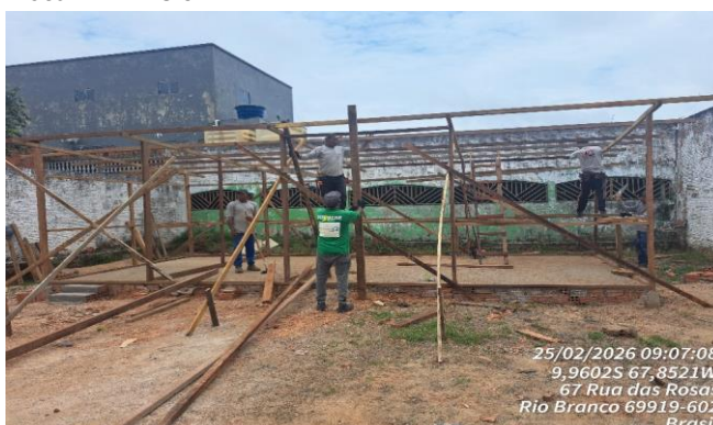
Imagem 12 EXECUÇÃO DE REFEITÓRIO, DEPÓSITO E VESTIÁRIO
