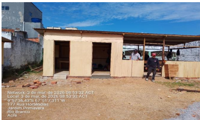
Imagem 14 EXECUÇÃO DE REFEITÓRIO, DEPÓSITO E VESTIÁRIO
