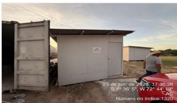
Imagem 4 Execução do escritório
