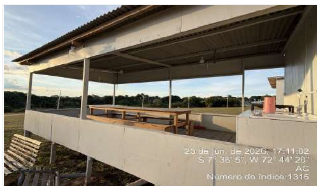
Imagem 5 Execução de Refeitório
