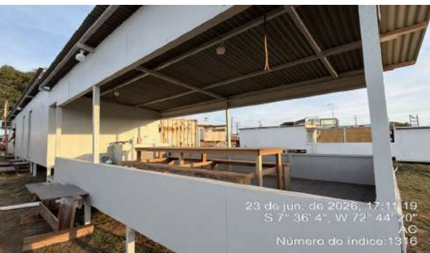
Imagem 6 Execução de Refeitório
