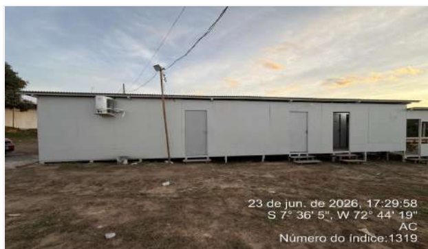
Imagem 3 Execução de almoxarifado
