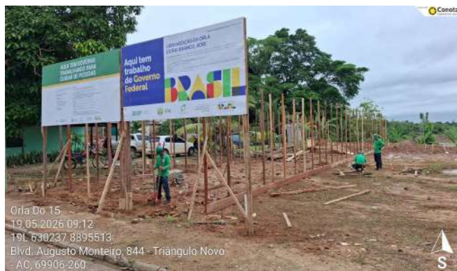
Imagem 5 Instalação de placa de obra
