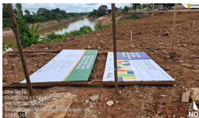
Imagem 4 Instalação de placa de obra
