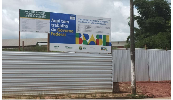
Imagem 2 Instalação de placa de obra
