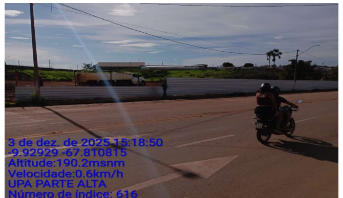
Imagem 4 Execução de tapume com telha metálica
