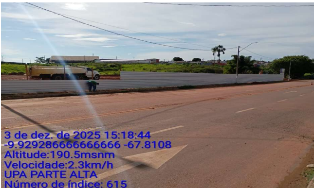
Imagem 5 Execução de tapume com telha metálica
