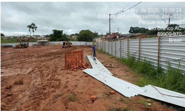
Imagem 3 Execução de tapume com telha metálica
