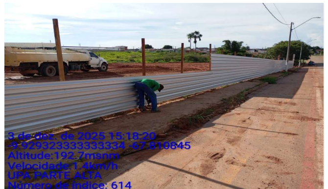
Imagem 6 Execução de tapume com telha metálica
