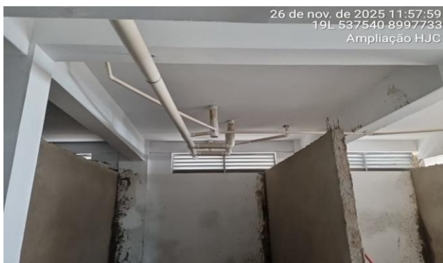
Imagem 21 REDE DE ESGOTO EXECUTADA
