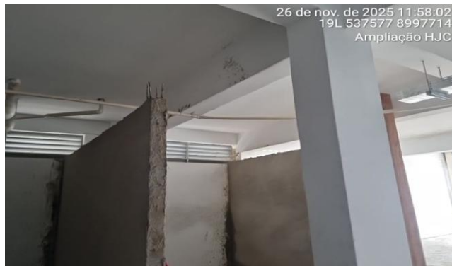
Imagem 20 REDE DE ESGOTO EXECUTADA
