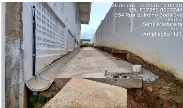
Imagem 1 LASTRO DE CONCRETO EXECUTADO
