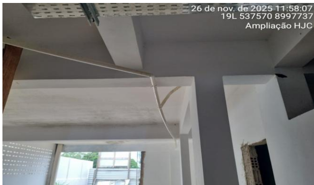
Imagem 19 REDE DE ESGOTO EXECUTADA
