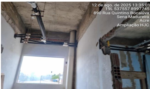
Imagem 41 DRENAGEM - TUBULAÇÃO 200 MM
