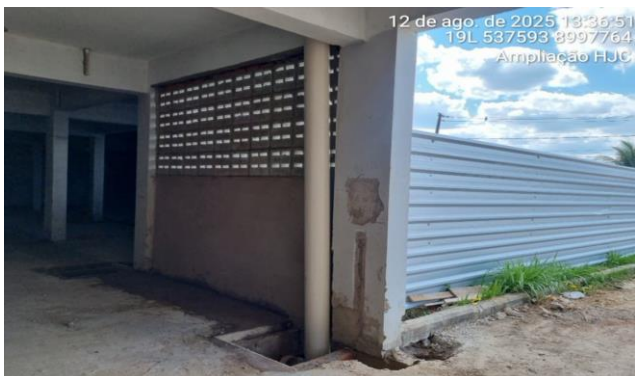
Imagem 39 DRENAGEM - TUBULAÇÃO 200 MM
