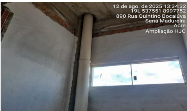
Imagem 42 DRENAGEM - TUBULAÇÃO 200 MM
