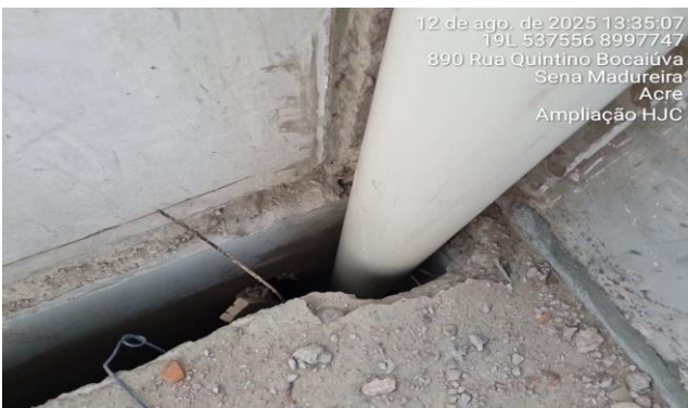
Imagem 40 DRENAGEM - TUBULAÇÃO 200 MM
