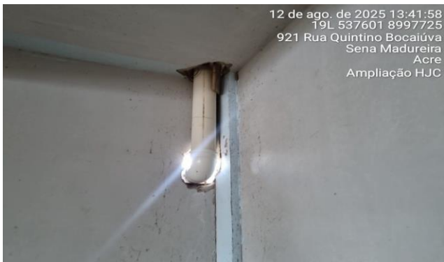
Imagem 37 DRENAGEM - TUBULAÇÃO 200 MM
