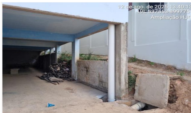
Imagem 38 DRENAGEM - TUBULAÇÃO 200 MM
