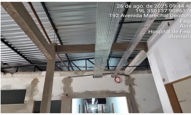
Imagem 6 SERVIÇO DE CONCRETAGEM
