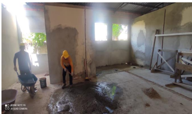
Imagem 5 Chapisco e Reboco
