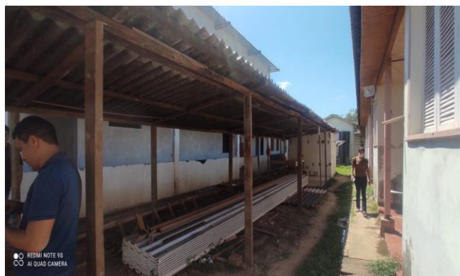
Imagem 2 Canteiro de Obras
