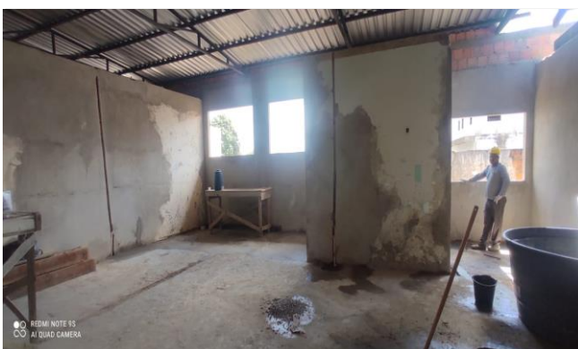
Imagem 6 Chapisco e Reboco
