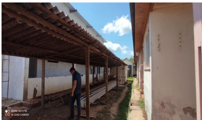
Imagem 3 Canteiro de Obras
