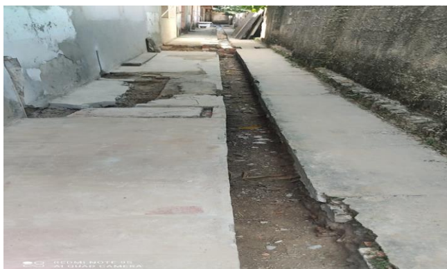
Imagem 4 Escavação de Vala
