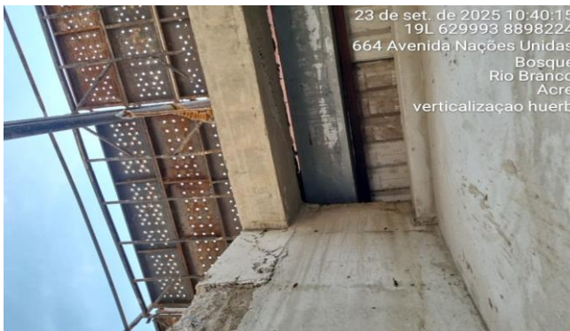
Imagem 9 EXECUÇÃO DE ESTRUTURA DE CONCRETO
