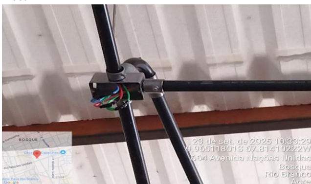
Imagem 36 INSTALAÇÕES ELÉTRICAS EXECUTADAS
