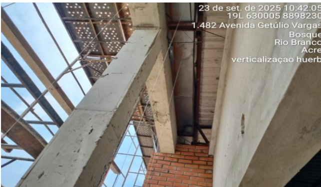
Imagem 8 EXECUÇÃO DE ESTRUTURA DE CONCRETO
