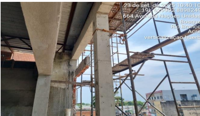
Imagem 10 EXECUÇÃO DE ESTRUTURA DE CONCRETO
