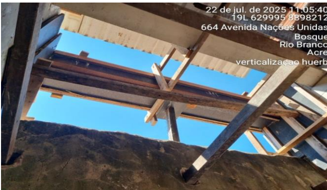
Imagem 12 EXECUÇÃO DE ESTRUTURA DE CONCRETO
