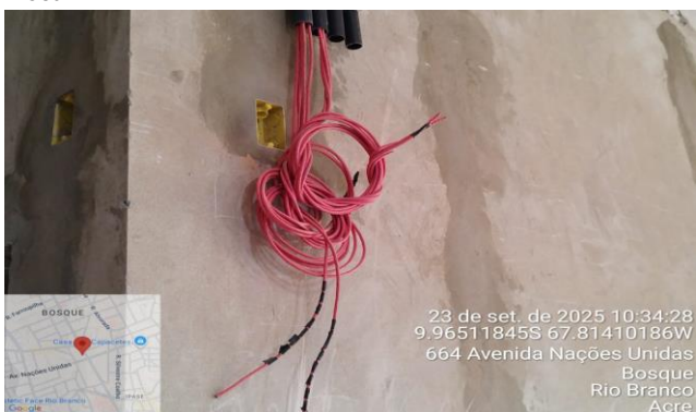
Imagem 35 INSTALAÇÕES ELÉTRICAS EXECUTADAS
