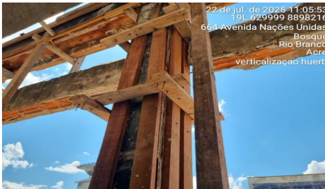
Imagem 11 EXECUÇÃO DE ESTRUTURA DE CONCRETO
