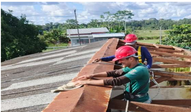
Imagem 33 REMOÇÃO DE TELHAMENTO EXISTENTE, SEM REAPROVEITAMENTO
