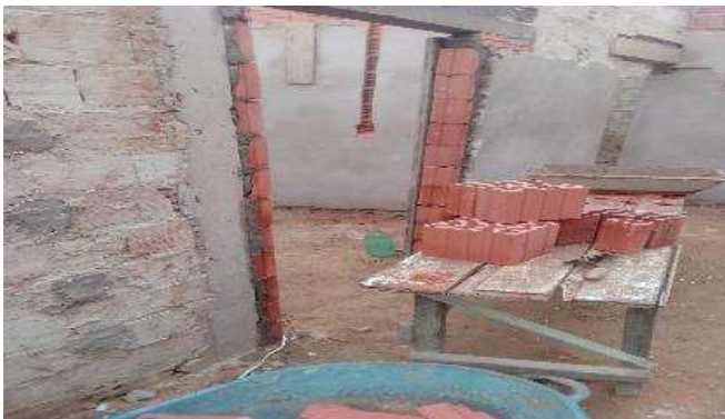
Imagem 17 EXECUÇÃO DE ALVENARIA DE VEDAÇÃO DE BLOCOS CERÂMICOS FURADOS (ESPESSURA 9CM)
