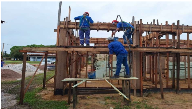
Imagem 32 CONCRETAGEM MANUAL DE SUPERESTRUTURA (VIGAS SUPERIORES)
