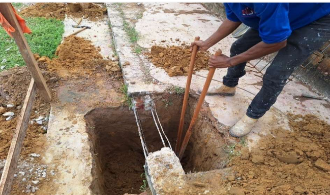
Imagem 9 ESCAVAÇÃO MANUAL PARA BLOCO DE COROAMENTO OU SAPATA.
