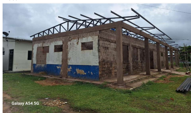
Imagem 5 INÍCIO DA EXECUÇÃO DA COBERTURA
