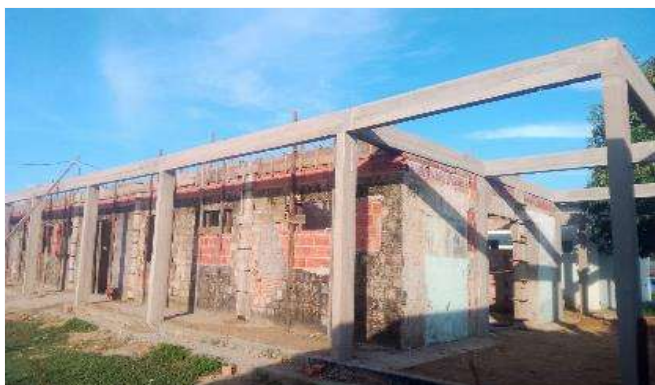
Imagem 35 DESFORMA DE SUPERESTRUTURA
