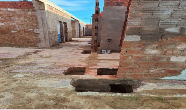
Imagem 7 ESCAVAÇÃO MANUAL PARA BLOCO DE COROAMENTO OU SAPATA.
