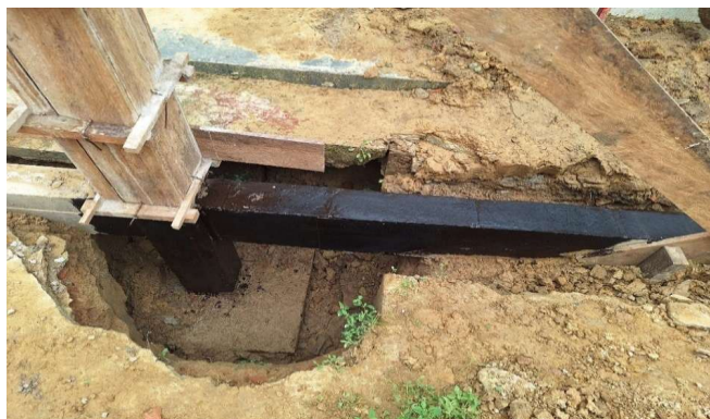
Imagem 16 IMPERMEABILIZAÇÃO DE ESTRUTURAS ENTERRADAS COM TINTA ASFÁLTICA
