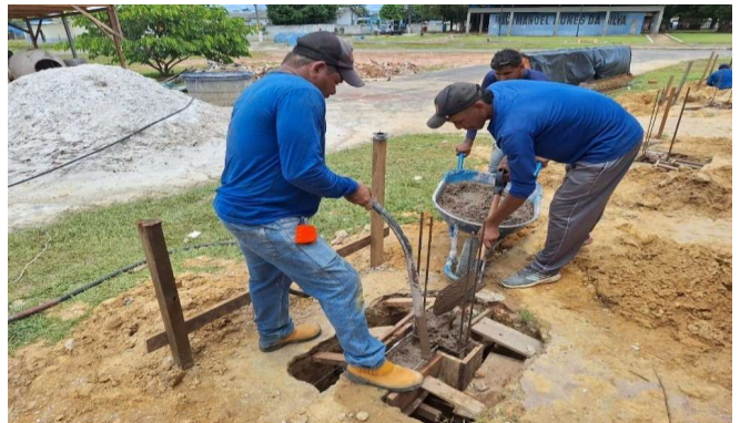
Imagem 12 MONTAGEM DE FORMA E ARMAÇÃO PARA INFRAESTRUTURA (SAPATAS)
