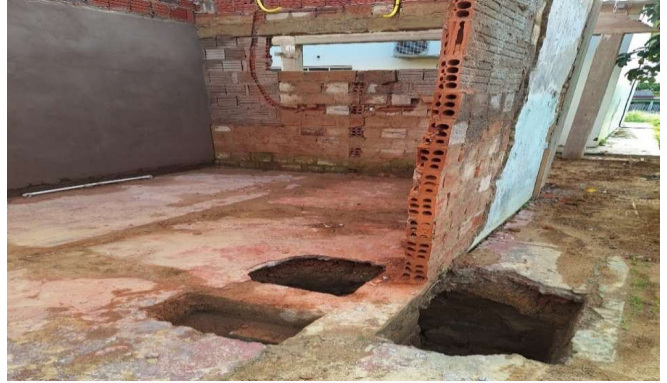
Imagem 8 ESCAVAÇÃO MANUAL PARA BLOCO DE COROAMENTO OU SAPATA.
