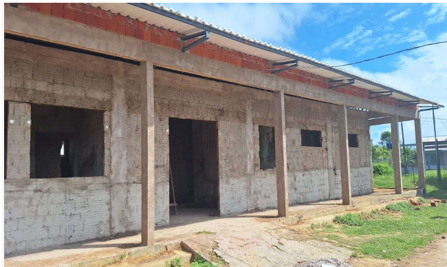
Imagem 2 VISTA FRONTAL DA OBRA
