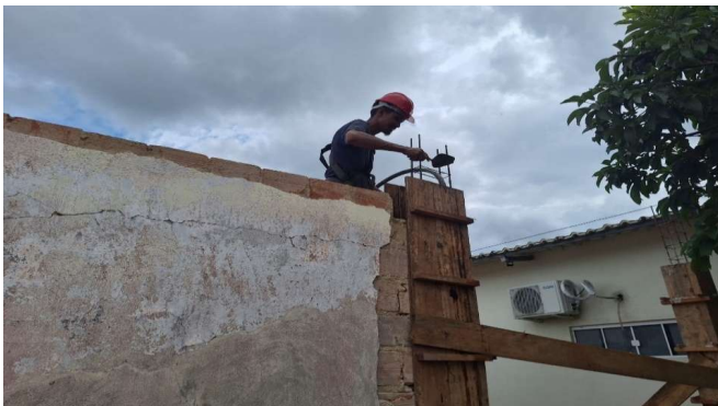
Imagem 31 CONCRETAGEM MANUAL DE SUPERESTRUTURA (PILARES)
