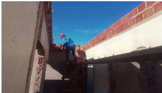
Imagem 18 EXECUÇÃO DE ALVENARIA DE VEDAÇÃO DE BLOCOS CERÂMICOS FURADOS (ESPESSURA 9CM)
