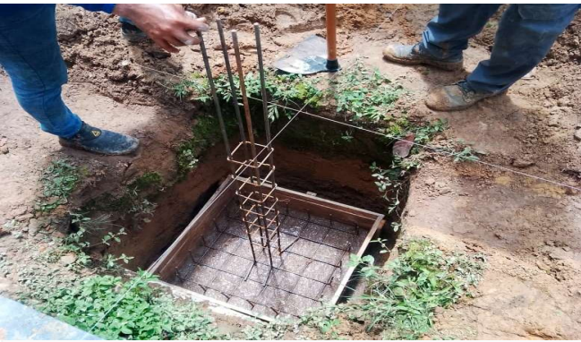
Imagem 11 MONTAGEM DE FORMA E ARMAÇÃO PARA INFRAESTRUTURA (SAPATAS)
