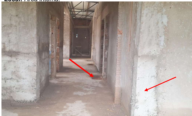
Imagem 3 PILARES E SAPATAS EXECUTADAS
