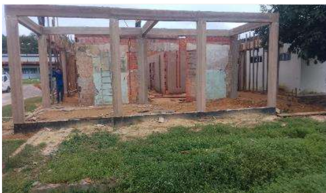
Imagem 36 DESFORMA DE SUPERESTRUTURA
