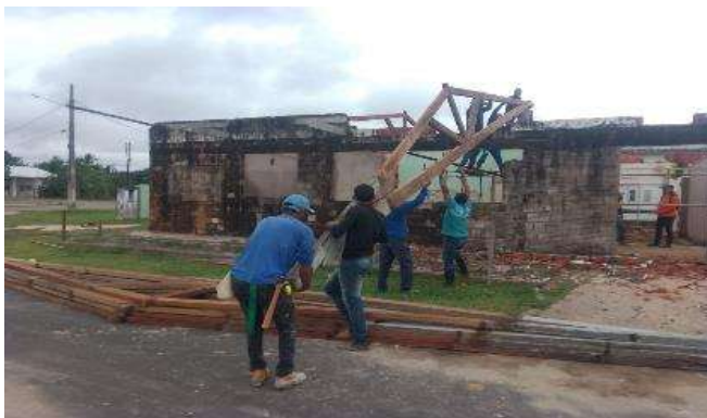
Imagem 34 REMOÇÃO DE ESTRUTURA EM MADEIRA DA COBERTURA, SEM APROVEITAMENTO
