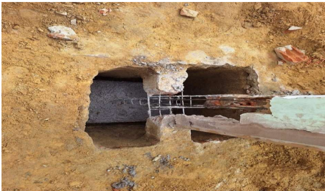
Imagem 13 CONCRETAGEM MANUAL DE INFRAESTRUTURA (SAPATAS)
