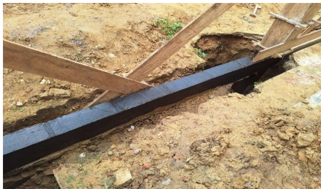
Imagem 14 IMPERMEABILIZAÇÃO DE ESTRUTURAS ENTERRADAS COM TINTA ASFÁLTICA
