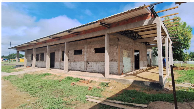
Imagem 1 VISTA FRONTAL DA OBRA
