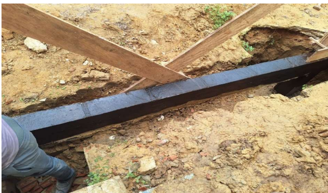
Imagem 15 IMPERMEABILIZAÇÃO DE ESTRUTURAS ENTERRADAS COM TINTA ASFÁLTICA
