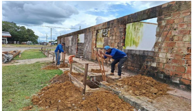
Imagem 10 ESCAVAÇÃO MANUAL PARA BLOCO DE COROAMENTO OU SAPATA.
