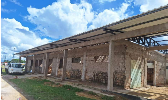
Imagem 6 VISTA FRONTAL DA OBRA
