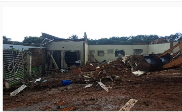
Imagem 13 DEMOLIÇÃO EM GERAL
