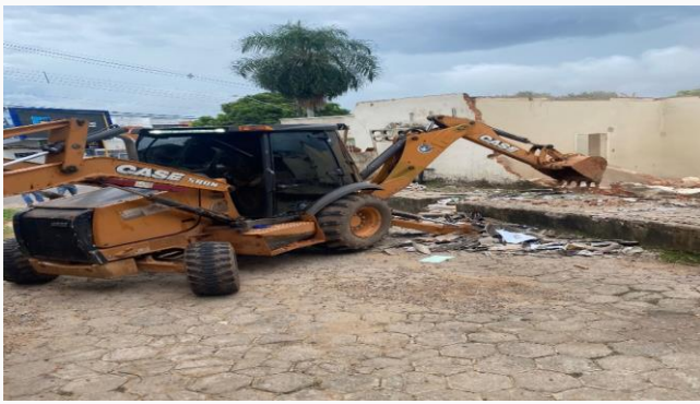
Imagem 7 DEMOLIÇÃO DE ALVENARIA
