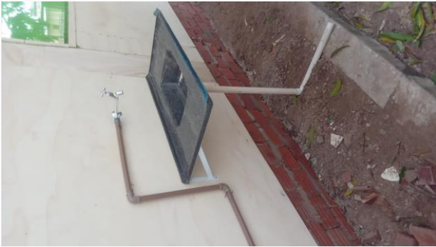
Imagem 18 PIA DO CANTEIRO
