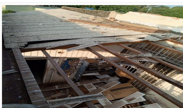
Imagem 15 DEMOLIÇÃO EM GERAL
