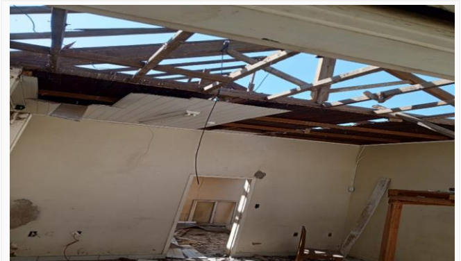
Imagem 9 RETIRADA DA COBERTURA
