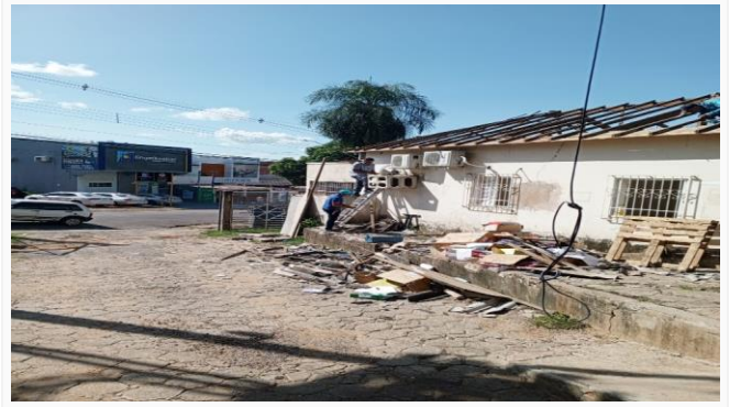
Imagem 8 RETIRADA DE TELHAS
