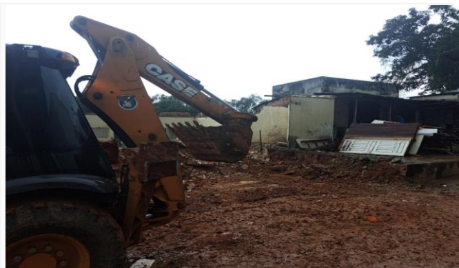
Imagem 12 DEMOLIÇÃO DE CONCRETO
