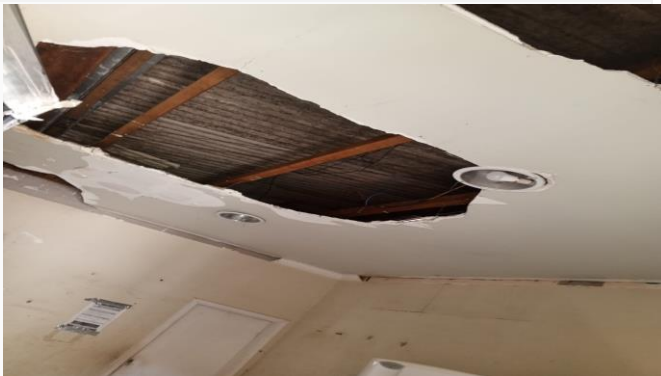
Imagem 8 RETIRADA DE FORRO
