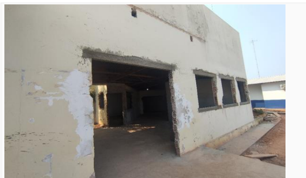
Imagem 17 Execução de verga em janelas e portas
