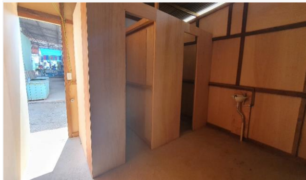
Imagem 3 Canteiro de obra
