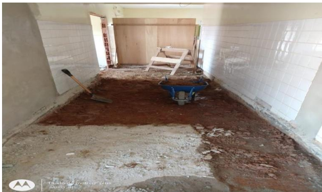
Imagem 9 Demolição de contrapiso
