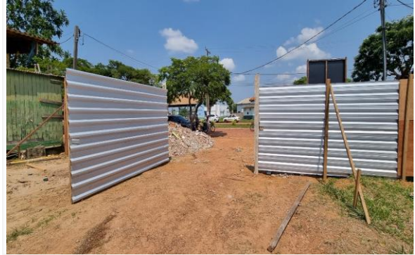
Imagem 26 Execução de tapume
