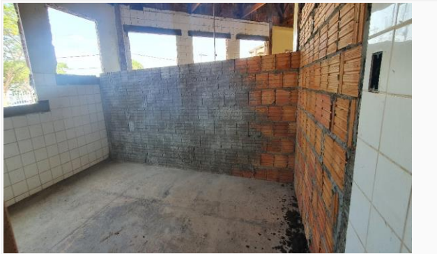
Imagem 13 Execução de alvenaria
