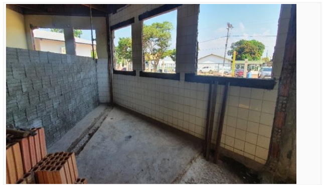
Imagem 16 Execução de verga em janelas
