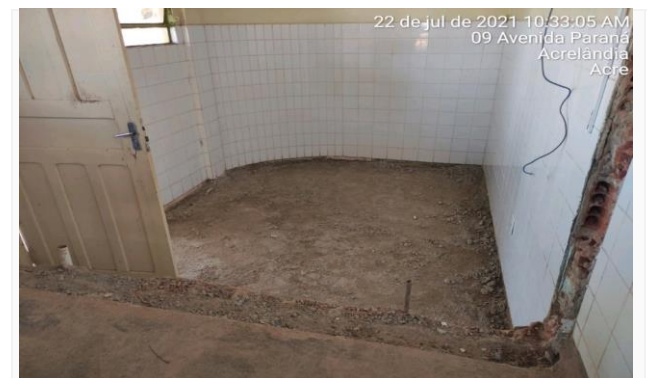
Imagem 12 Demolição de contrapiso
