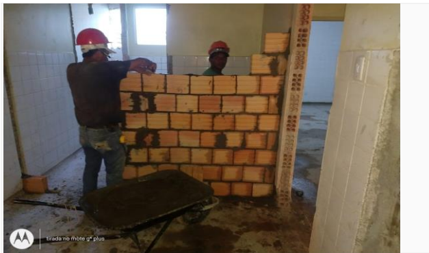
Imagem 15 Execução de alvenaria
