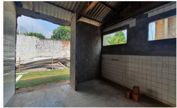
Imagem 20 Execução de chapisco e verga em janelas
