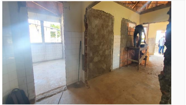
Imagem 14 Execução de alvenaria e chapisco
