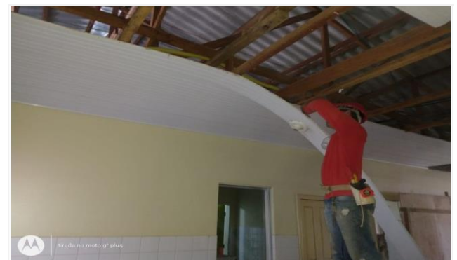
Imagem 10 Retirada de forro
