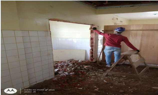
Imagem 1 Demolição de alvenaria
