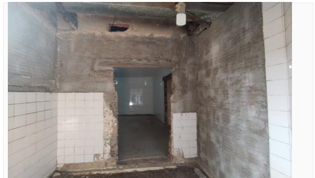
Imagem 18 Execução de chapisco
