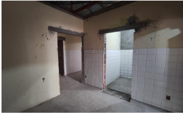
Imagem 19 Execução de verga em portas
