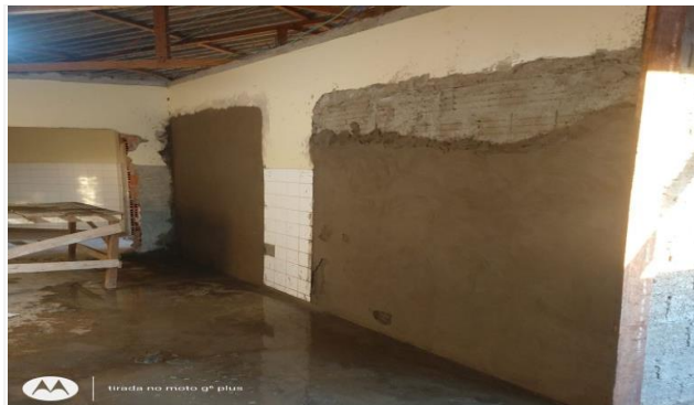
Imagem 21 Execução de massa única
