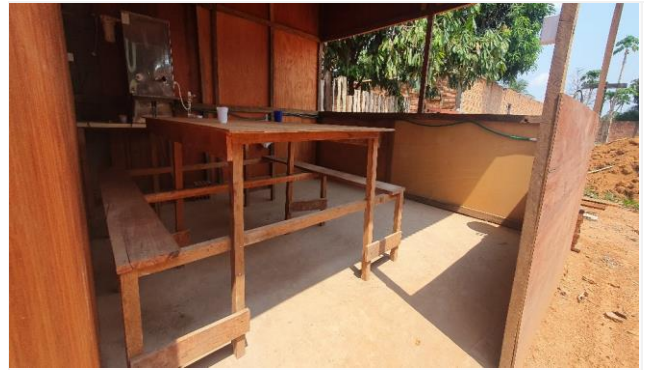
Imagem 4 Canteiro de obra
