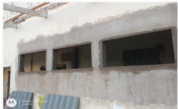
Imagem 22 Execução de massa única
