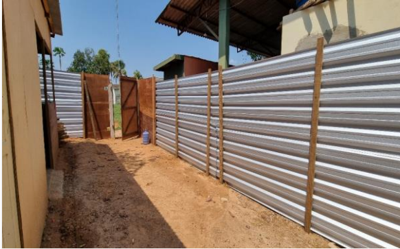
Imagem 25 Execução de tapume
