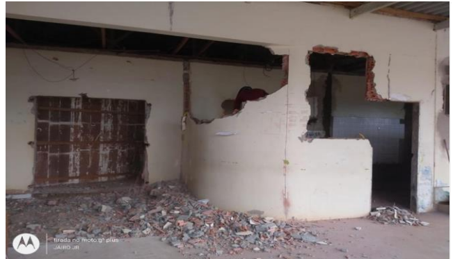
Imagem 2 Demolição de alvenaria
