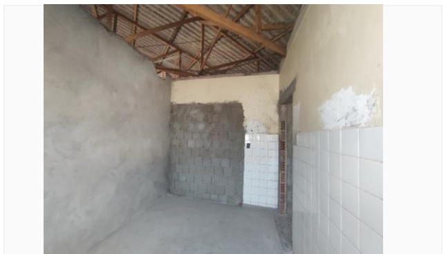
Imagem 24 Execução de chapisco
