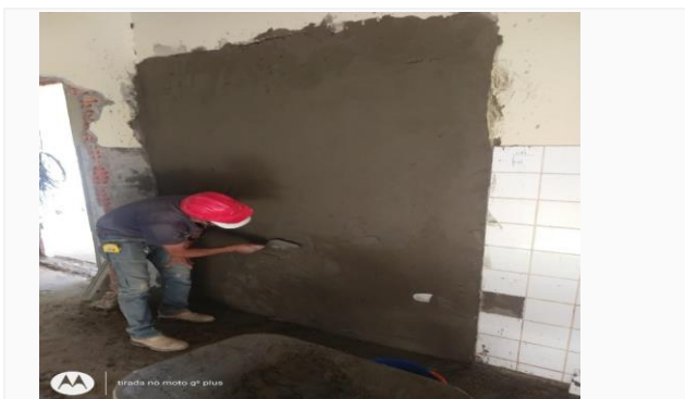
Imagem 23 Execução de massa única
