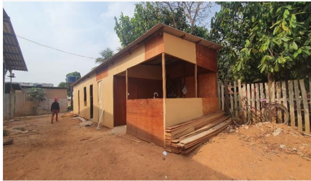
Imagem 7 Canteiro de obra
