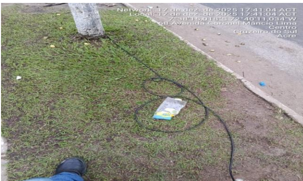
Imagem 20 CABO FLEXIVEL PVC 750 V, 2 CONDUTORES DE 4,0 MM2
