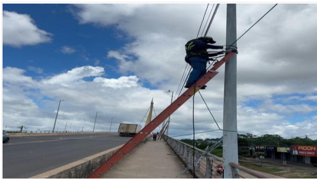
Imagem 22 INSTALAÇÃO DAS ESTRELAS NA PONTE
