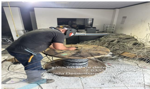
Imagem 3 ESTRELAS CRUZ 2D COM MANGUEIRA LED, EXCLUSIVE ESTRUTURA EM FERRO
