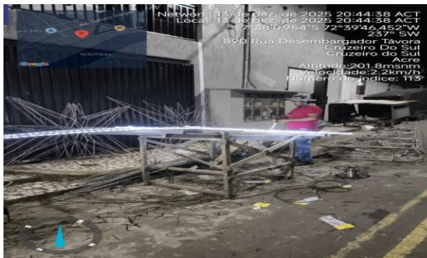
Imagem 2 ESTRELAS CRUZ 2D COM MANGUEIRA LED, EXCLUSIVE ESTRUTURA EM FERRO
