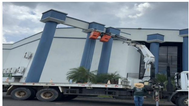
Imagem 23 GUINDAUTO HIDRAULICO USADO NO TEATRO
