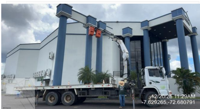
Imagem 21 GUINDAUTO HIDRAULICO USADO NO TEATRO
