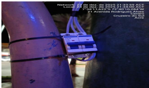
Imagem 19 DISJUNTOR BIPOLAR
