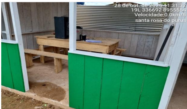
Imagem 33 CANTEIRO DE OBRAS
