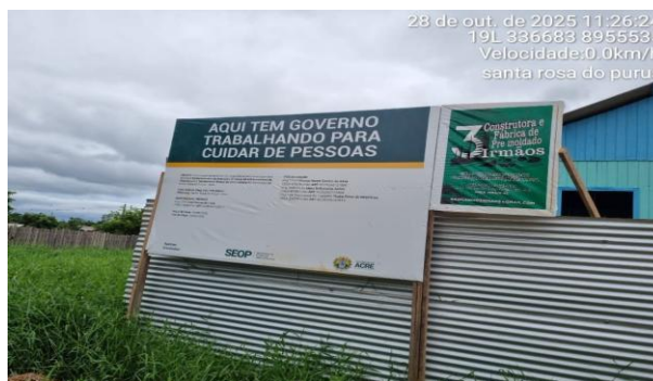
Imagem 35 CANTEIRO DE OBRAS
