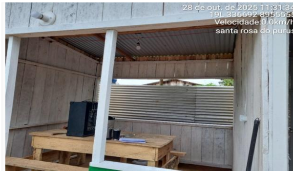
Imagem 34 CANTEIRO DE OBRAS
