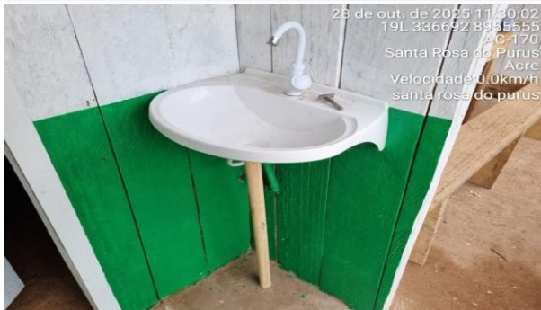
Imagem 31 CANTEIRO DE OBRAS
