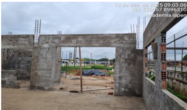
Imagem 9 SERVIÇOS DE ESTRUTURAS
