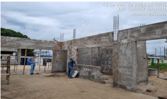
Imagem 10 SERVIÇOS DE ESTRUTURAS
