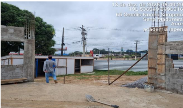
Imagem 8 SERVIÇOS DE ESTRUTURAS
