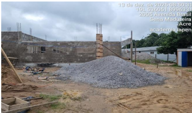
Imagem 11 SERVIÇOS DE ESTRUTURAS
