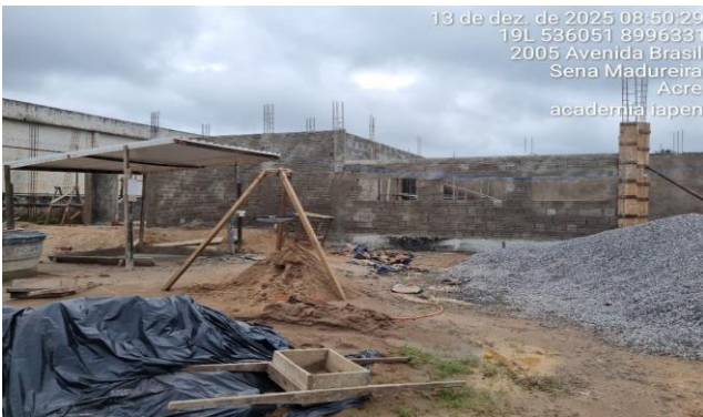
Imagem 12 SERVIÇOS DE ESTRUTURAS
