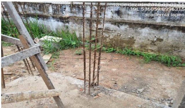
Imagem 7 SERVIÇOS DE ESTRUTURAS
