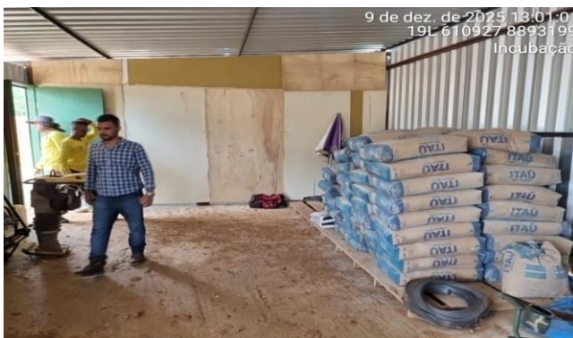
Imagem 6 CANTEIRO DE OBRAS
