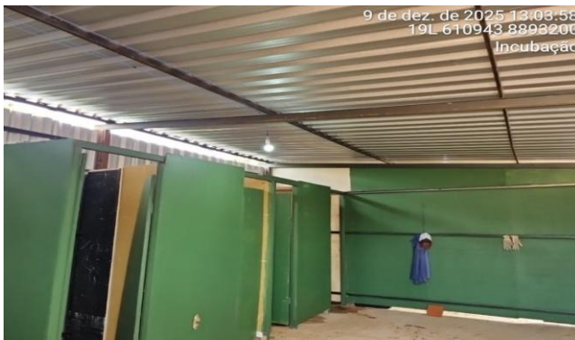
Imagem 2 CANTEIRO DE OBRAS
