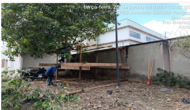
Imagem 3 Montagem do canteiro de obras.
