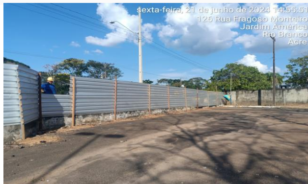
Imagem 1 Instalação do Tapume do canteiro de obras
