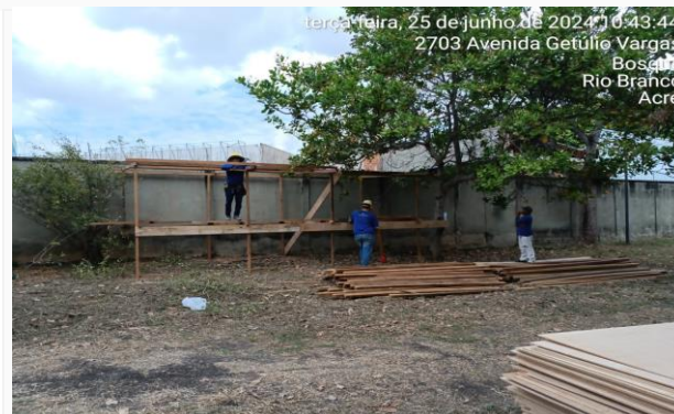
Imagem 2 Montagem do canteiro de obras.
