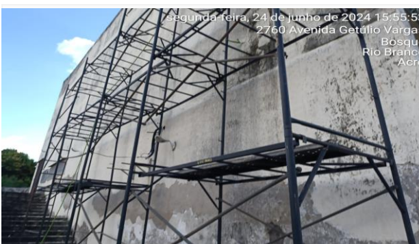
Imagem 6 Montagem de Andaime na fachada lateral esquerda.
