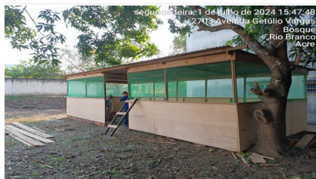
Imagem 5 Montagem do canteiro de obras ( banheiros, refeitório).
