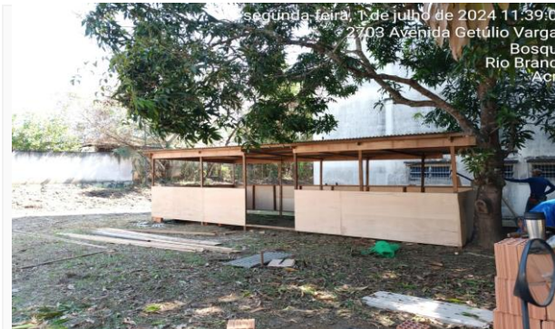
Imagem 4 Montagem do canteiro de obras ( banheiros).
