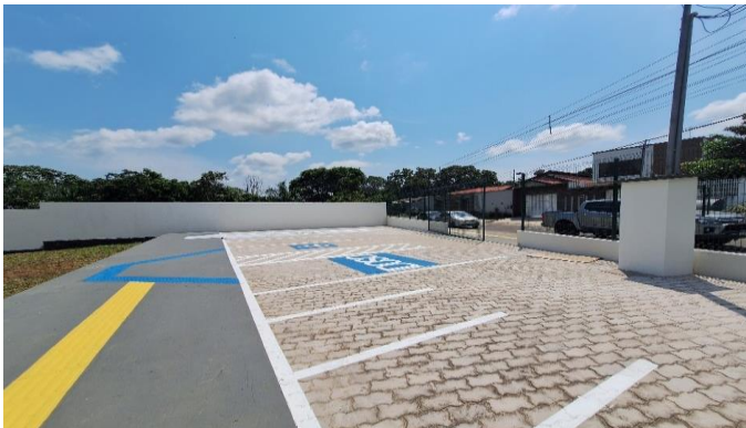
Imagem 29 SINALIZACAO HORIZONTAL COM TINTA RETRORREFLETIVA A BASE DE RESINA ACRILICA.
