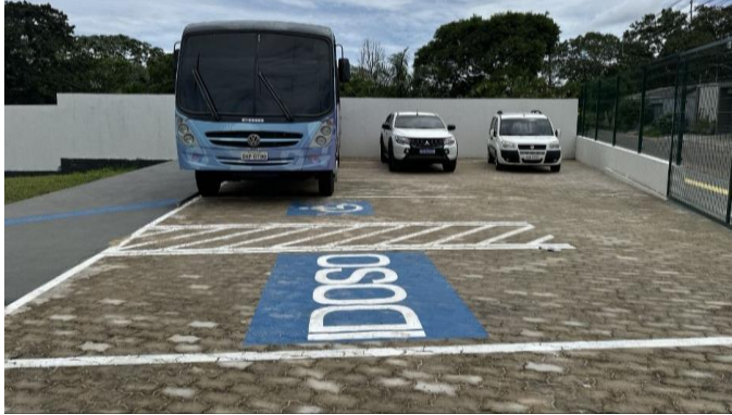
Imagem 31 SINALIZAÇÃO HORIZONTAL COM TINTA RETRORREFLETIVA A BASE DE RESINA ACRILICA.
