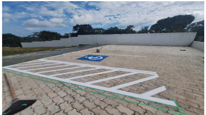
Imagem 30 SINALIZACAO HORIZONTAL COM TINTA RETRORREFLETIVA A BASE DE RESINA ACRILICA.
