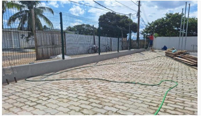
Imagem 22 LIMPEZA DE SUPERFÍCIE COM JATO DE ALTA PRESSÃO.
