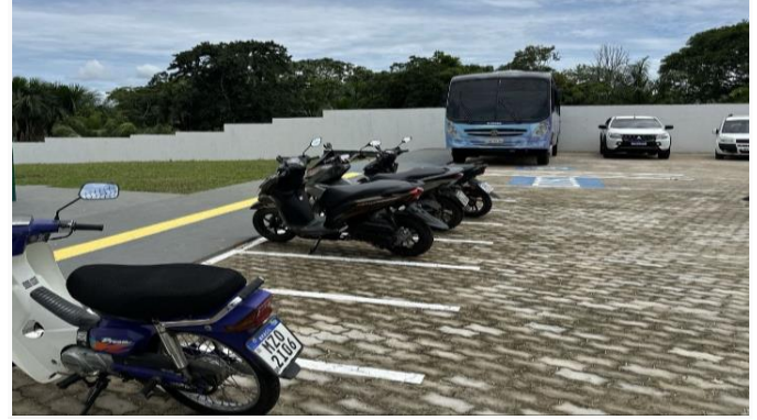
Imagem 32 SINALIZAÇÃO HORIZONTAL COM TINTA RETRORREFLETIVA A BASE DE RESINA ACRILICA.
