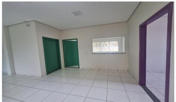
Imagem 20 LIMPEZA DE PISO CERÂMICO
