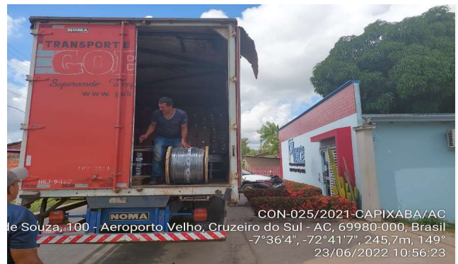
Imagem 10 Recebimento de cabos multipolar, flexível e galvanizado
