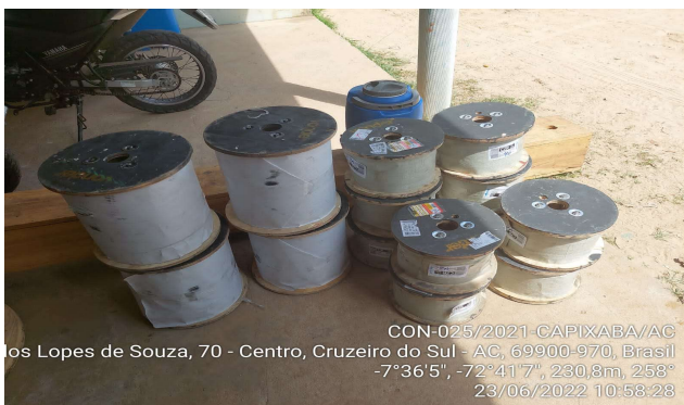
Imagem 11 Recebimento de cabos multipolar, flexível e galvanizado
