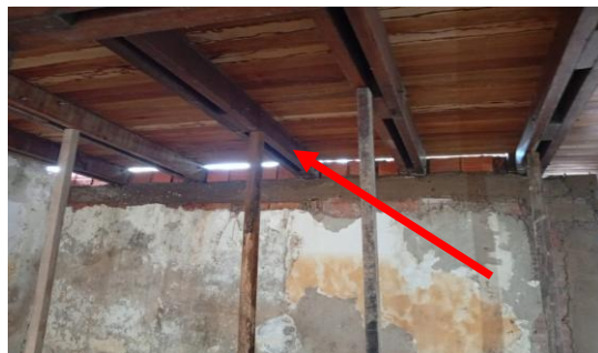
Imagem 45 Escoramento para alinhamento de vigas
