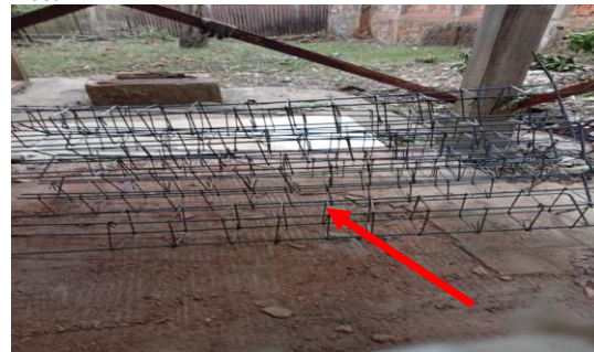
Imagem 33 Montagem de ferragem
