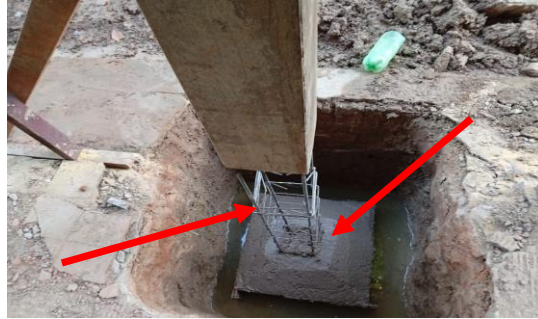
Imagem 31 Sapatas concreto e montagem de ferragem
