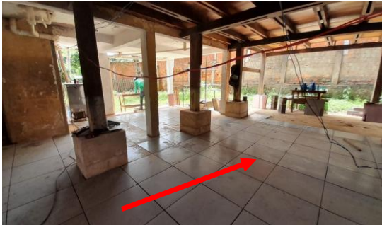
Imagem 16 Assentamento de revestimento
