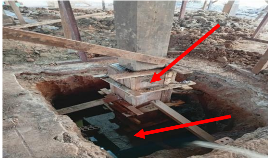
Imagem 30 Sapatas concreto e formas
