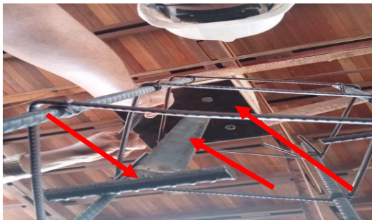
Imagem 45 Chapa metálica e chumbador
