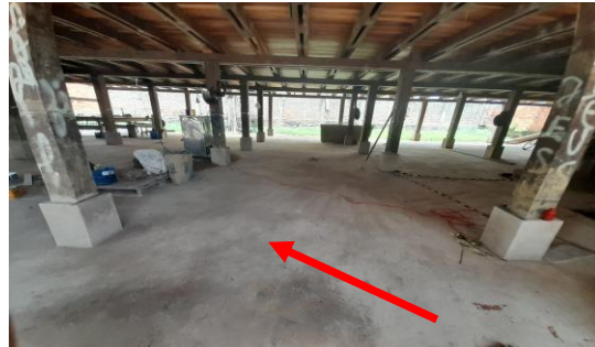
Imagem 14 Execução de contra piso
