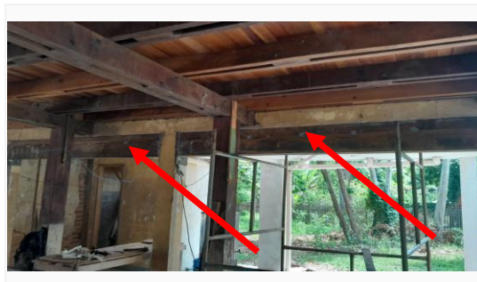
Imagem 43 Perfil dobrado e instalado para reforço
