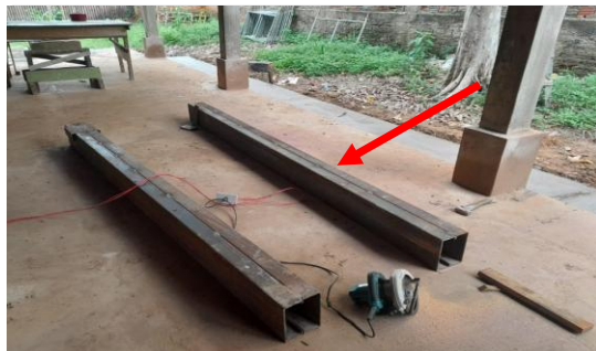
Imagem 44 Perfil dobrado para reforço
