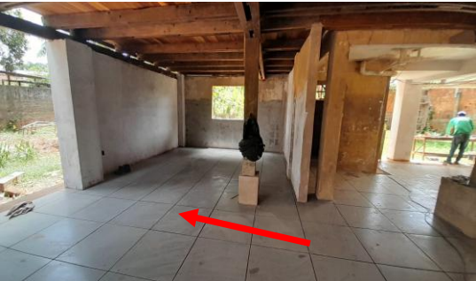
Imagem 15 Assentamento de revestimento
