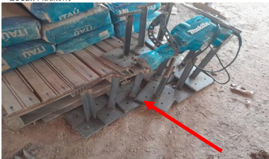
Imagem 34 Chapa de aço para fixação pilares
