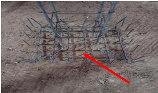
Imagem 32 Sapatas montagem de ferragem
