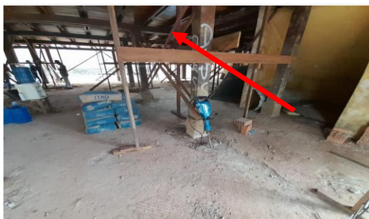
Imagem 46 Escoramento para alinhamento de vigas
