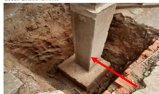
Imagem 35 Concretagem de sapatas e pilares
