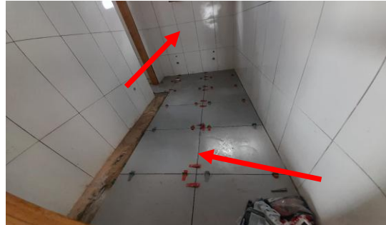
Imagem 20 Assentamento de revestimento paredes e piso
