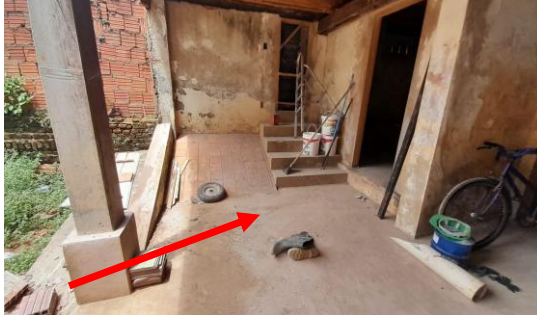
Imagem 13 Execução de contra piso
