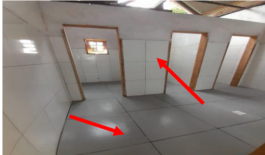
Imagem 22 Assentamento de revestimento paredes e piso
