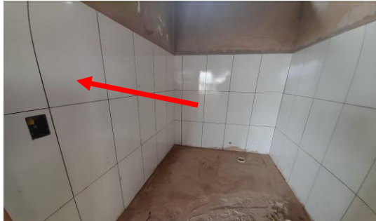
Imagem 21 Assentamento de revestimento paredes e conta piso
