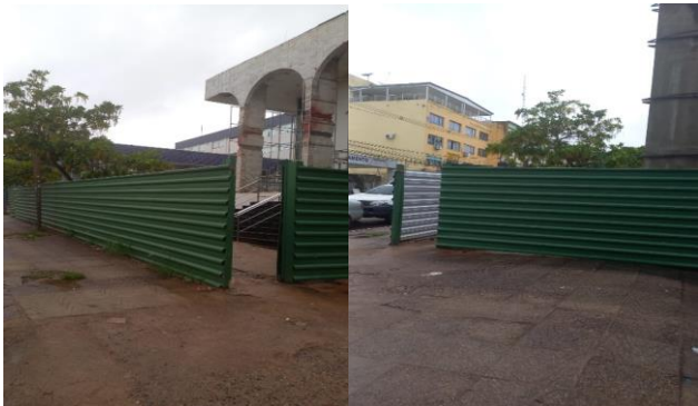
Imagem 9 EXECUÇÃO DE TAPUME
