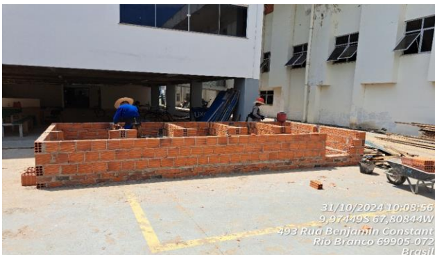
Imagem 11 EXECUÇÃO DE SANITÁRIO/VESTIÁRIO
