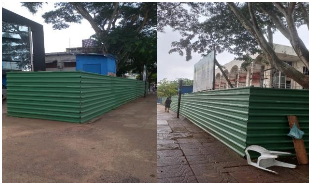
Imagem 8 EXECUÇÃO DE TAPUME
