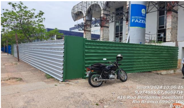
Imagem 7 EXECUÇÃO DE TAPUME
