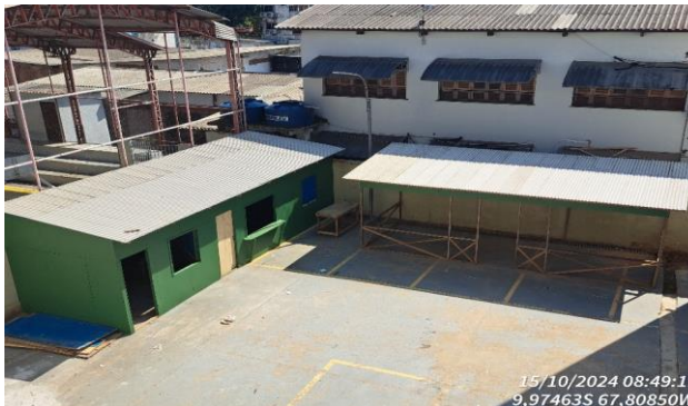
Imagem 10 EXECUÇÃO DE ESCRITÓRIO, DEPÓSITO E REFEITÓRIO
