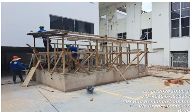
Imagem 12 EXECUÇÃO DE SANITÁRIO/VESTIÁRIO
