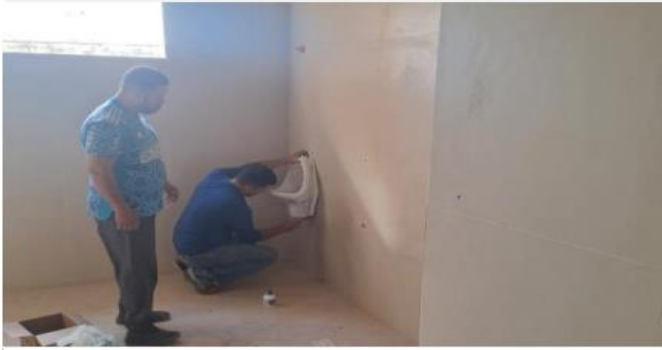
Item: Descrição: INST. LOUÇAS BANHEIRO
