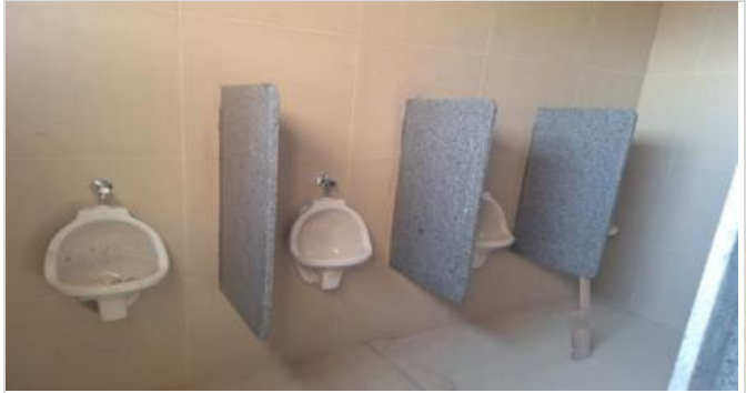
Item: Descrição: INST. LOUÇAS BANHEIRO
