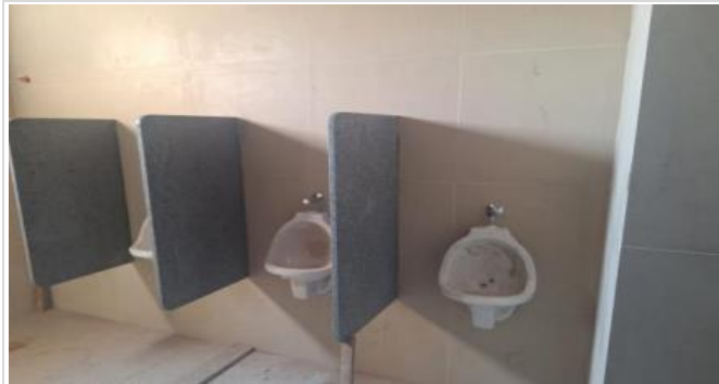
Item: Descrição: INST. LOUÇAS BANHEIRO
