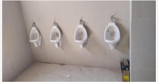
Item: Descrição: INST. LOUÇAS BANHEIRO
