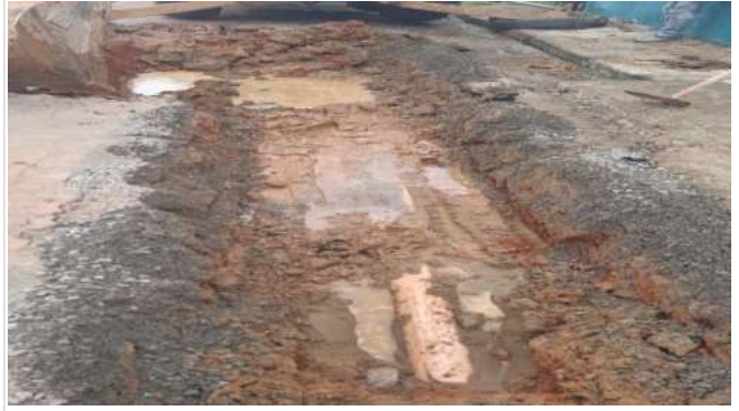
Descrição: Escavação de vala
