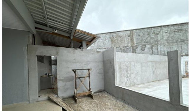
Imagem 20 EMBOÇO/MASSA ÚNICA, APLICADO MANUALMENTE.
