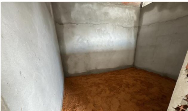
Imagem 21 EMBOÇO/MASSA ÚNICA, APLICADO MANUALMENTE; ATERRO MANUAL.
