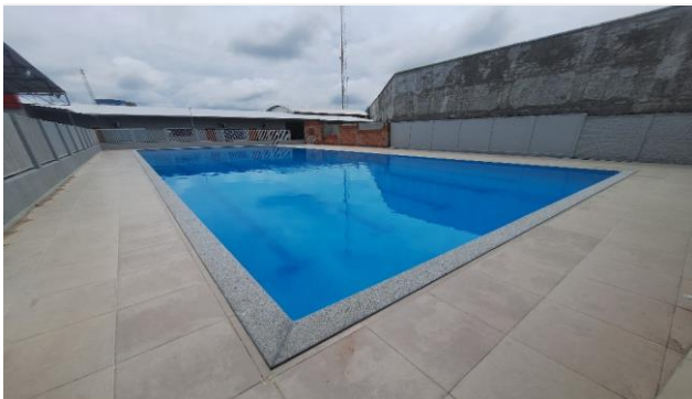
Imagem 79 REVESTIMENTO CERÂMICO PARA PISO COM PLACAS TIPO ESMALTADA EXTRA DE DIMENSÕES 45X45 CM APLICADA
