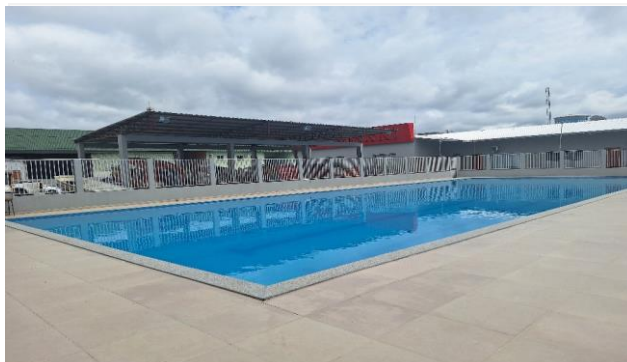
Imagem 80 REVESTIMENTO CERÂMICO PARA PISO COM PLACAS TIPO ESMALTADA EXTRA DE DIMENSÕES 45X45 CM APLICADA
