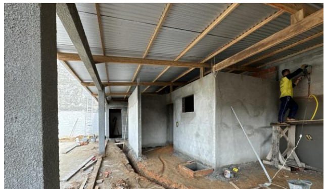
Imagem 22 EMBOÇO/MASSA ÚNICA, APLICADO MANUALMENTE; TRAMA DE MADEIRA.
