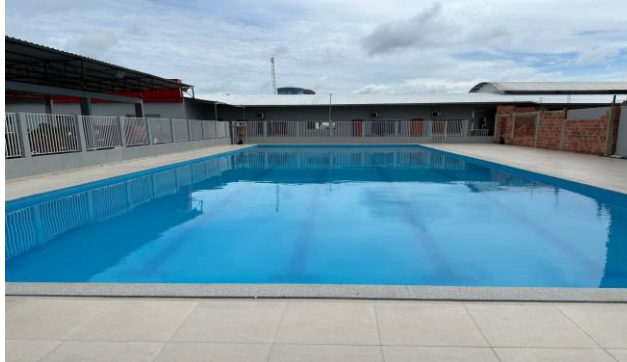
Imagem 82 REVESTIMENTO CERÂMICO PARA PISO COM PLACAS TIPO ESMALTADA EXTRA DE DIMENSÕES 45X45 CM APLICADA
