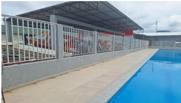
Imagem 81 REVESTIMENTO CERÂMICO PARA PISO COM PLACAS TIPO ESMALTADA EXTRA DE DIMENSÕES 45X45 CM APLICADA
