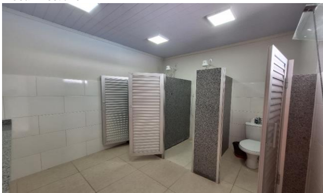
Imagem 53 DIVISORIA SANITÁRIA, TIPO CABINE, EM GRANITO CINZA POLIDO, ESP = 3CM
