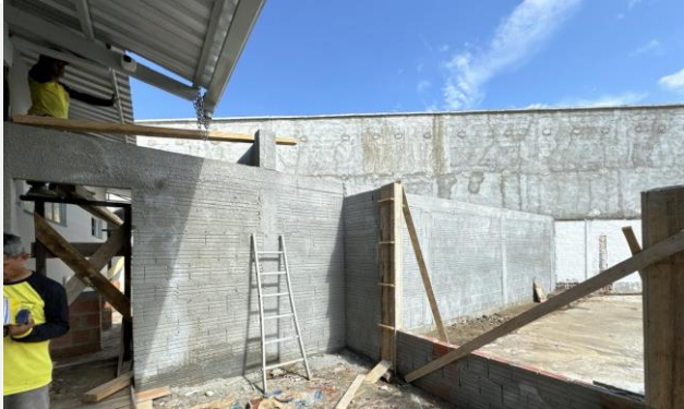
Imagem 19 CHAPISCO APLICADO EM ALVENARIAS.
