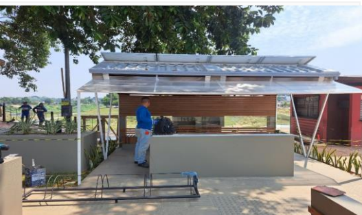
Imagem 37 ESTRUTURA DO ABRIGO
