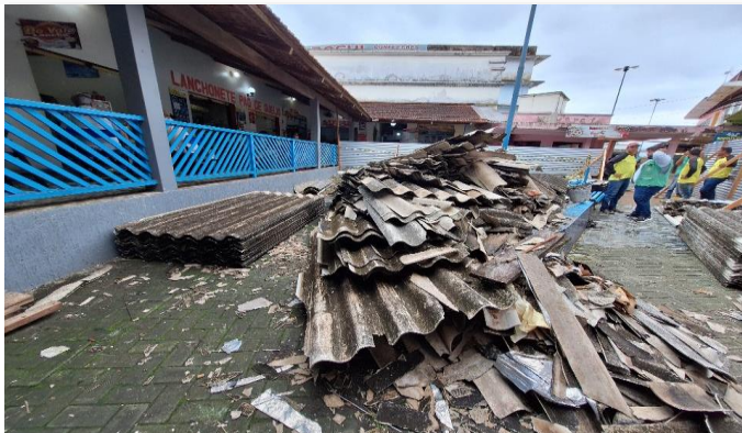
Imagem 7 REMOÇÃO DE TELHAS DE FIBROCIMENTO METÁLICA E CERÂMICA, DE FORMA MANUAL, SEM REAPROVEITAMENTO. AF_09/2023
