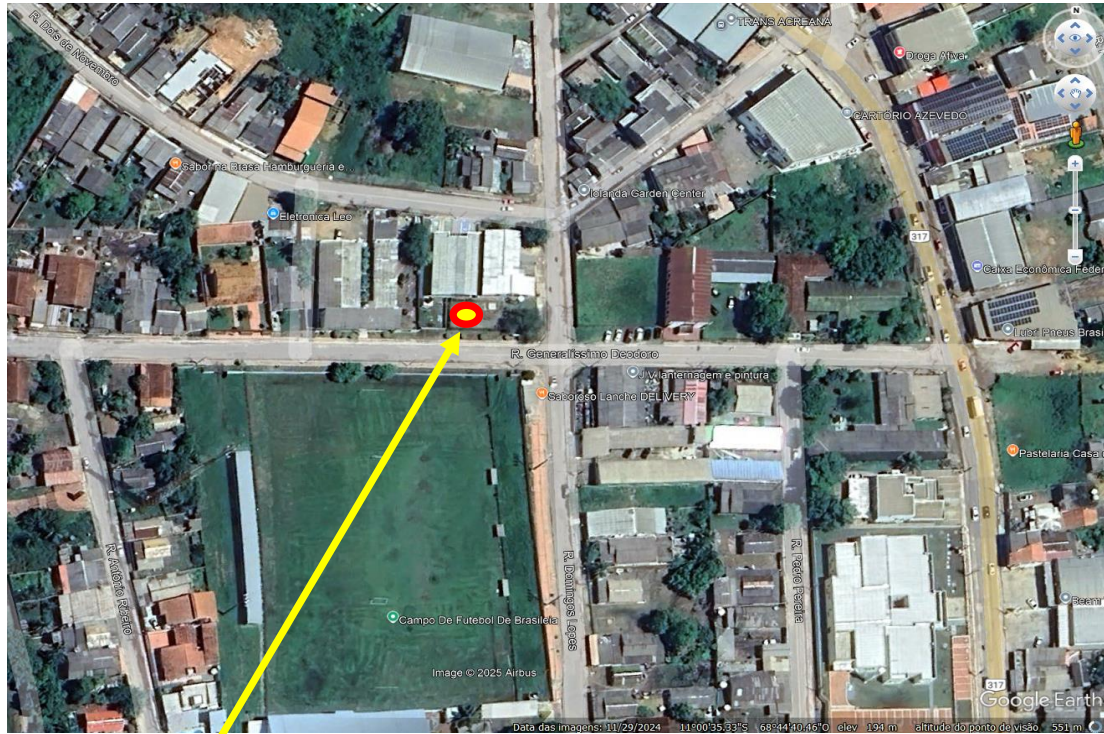
INSTALAÇÃO DE ATERRAMENTO E ELÉTRICA DA TORRE PARA FUNCIONAMENTO
