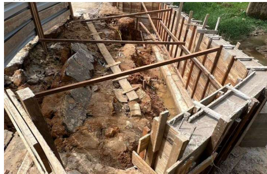
Imagem 32 MURO DE CONTENÇÃO CONCRETADO
