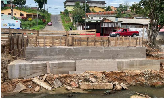
Imagem 31 ESTACAS, BLOCOS, VIGA E PILAR CONCRETADOS, PRONTOS PARA INSTALAÇÃO DA LONGARINA
