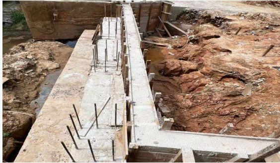
Imagem 33 MURO DE CONTENÇÃO CONCRETADO
