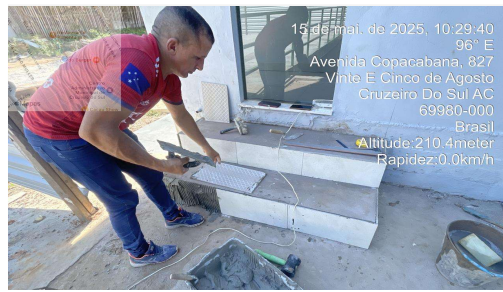
Imagem 18 EXECUÇÃO DE ESCADA
