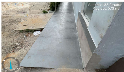
Imagem 19 EXECUÇÃO DE CALÇADA
