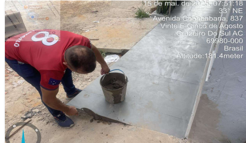
Imagem 20 EXECUÇÃO DE CALÇADA
