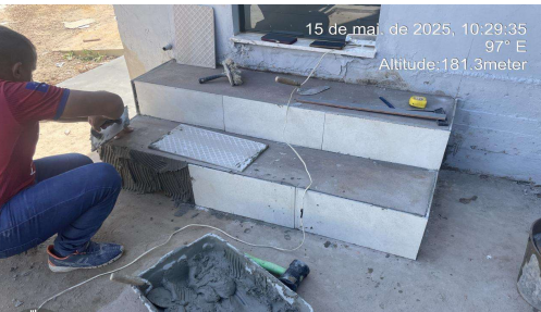
Imagem 21 EXECUÇÃO DE ESCADA
