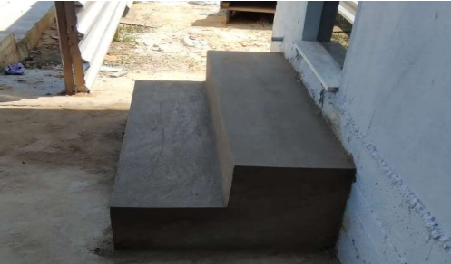
Imagem 17 EXECUÇÃO DE ESCADA
