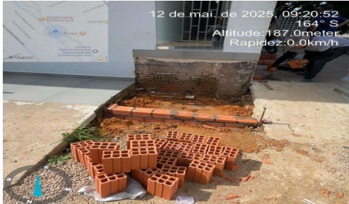
Imagem 15 EXECUÇÃO DE CALÇADA
