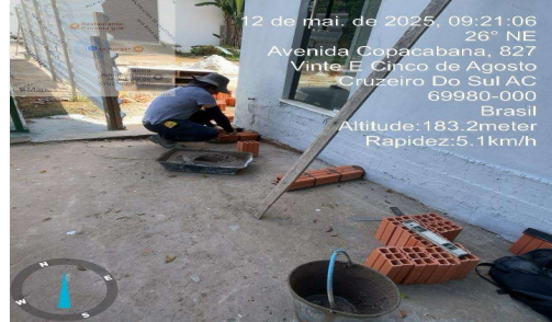
Imagem 16 EXECUÇÃO DE ESCADA
