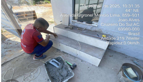
Imagem 22 EXECUÇÃO DE ESCADA
