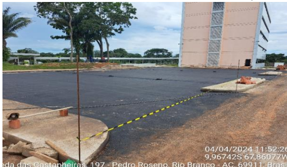
Imagem 12 PAVIMENTO EM CONCRETO ASFÁLTICO
