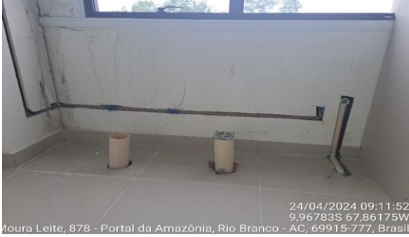
24/04/2024 09:11:52 9,96783S 67,86175W Moura Leite, 878 - Portal da Amazônia, Rio Branco - AC, 69915-777, Brasil Imagem 35 INSTALAÇÕES HIDRÁULICAS E SANITÁRIAS
