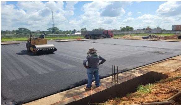
Imagem 11 EXECUÇÃO DE CONCRETO ASFÁLTICO
