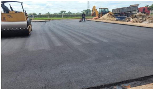
Imagem 10 EXECUÇÃO DE CONCRETO ASFÁLTICO
