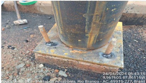
Imagem 42 CHUMBADORES E PLACA DE AÇO
