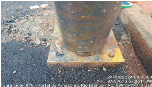
Imagem 41 CHUMBADORES E PLACA DE AÇO
