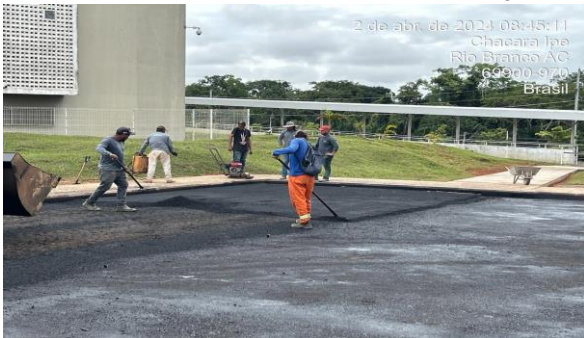
Imagem 9 EXECUÇÃO DE CONCRETO ASFÁLTICO
