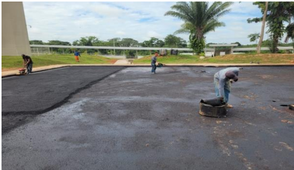
Imagem 7 PINTURA DE LIGAÇÃO - RR-2C E EXECUÇÃO DE CONCRETO ASFÁLTICO
