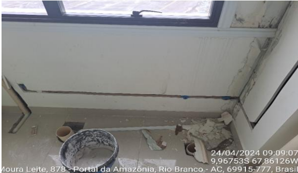
24/04/2024 09:09:07 9,96753S 67,86126W Moura Leite, 878 - Portal da Amazônia, Rio Branco - AC, 69915-777, Brasil Imagem 31 INSTALAÇÕES HIDRÁULICAS E SANITÁRIAS
