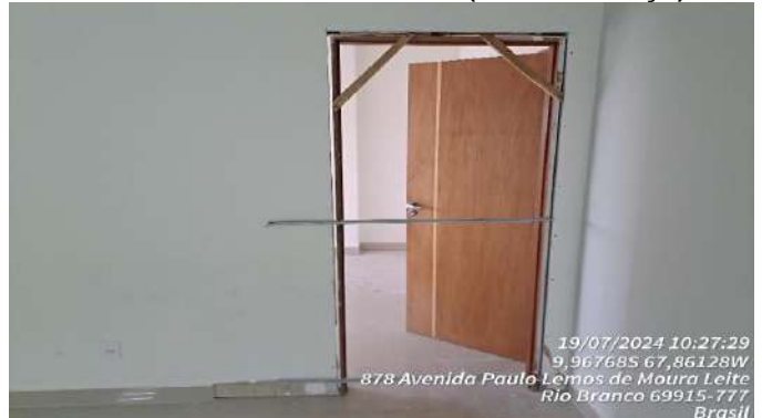
Imagem 130 REINSTALAÇÃO DE PORTA
