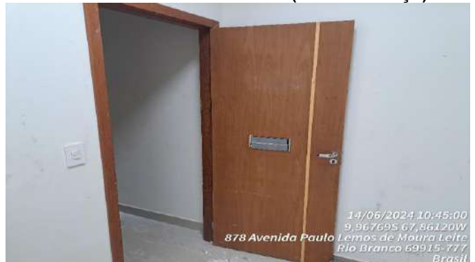
Imagem 118 REINSTALAÇÃO DE PORTA
