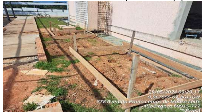
Imagem 162 LOCAÇÃO E ESCAVAÇÃO DA RAMPA DE INTERLIGAÇÃO AO PRÉDIO
