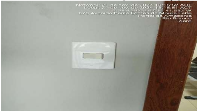
Imagem 279 INSTALAÇÃO DE INTERRUPTOR
