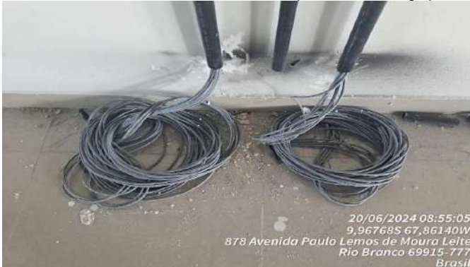
Imagem 253 INSTALAÇÃO DE ELETRODUTO E CABO DE LÓGICA
