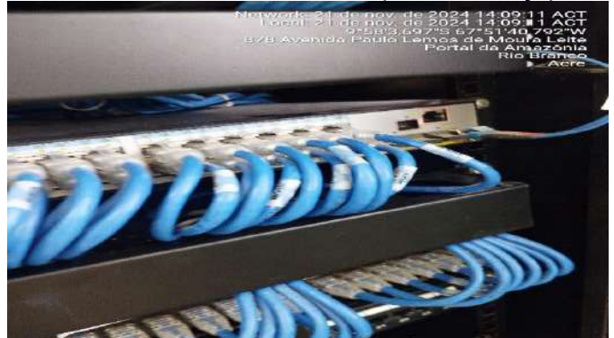
Imagem 266 INSTALAÇÃO DE PATCH CORDS
