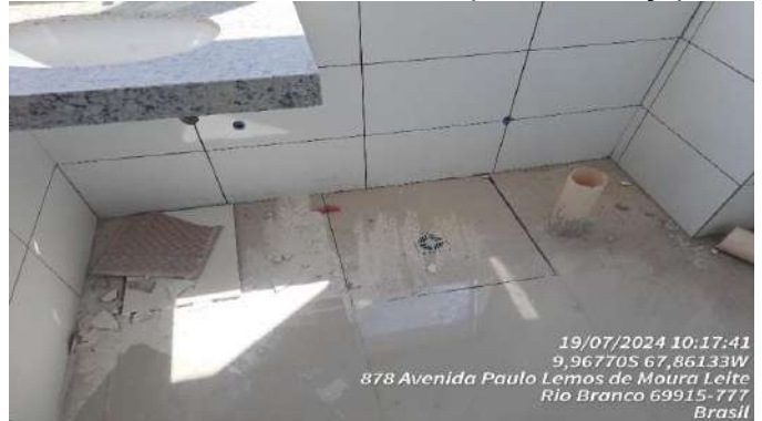
Imagem 146 REVESTIMENTO CERÂMICO DE PAREDE E DE PISO
