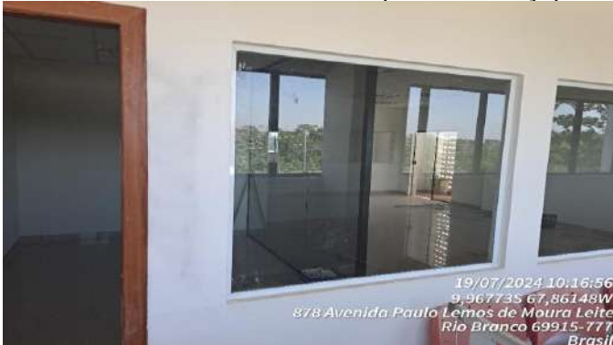
Imagem 125 REINSTALAÇÃO DE VIDRO
