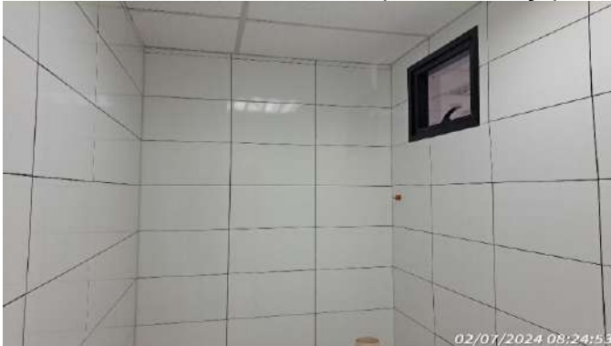
Imagem 145 REVESTIMENTO CERÂMICO DE PAREDE
