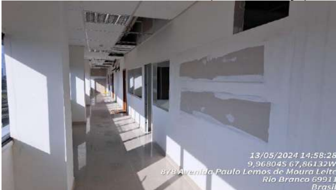
Imagem 91 PAREDES EM DRYWALL
