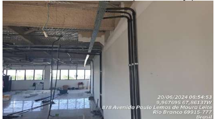
20/06/2024 08:54:53 9,96769S 67,86137W 878 Avenida Paulo Lemos de Moura Leite Rio Branco 69915-777 Brasil Imagem 250 INSTALAÇÃO DE CABEAMENTO DA REDE ELÉTRICA, ELETROCALHA E ELETRODUTO
