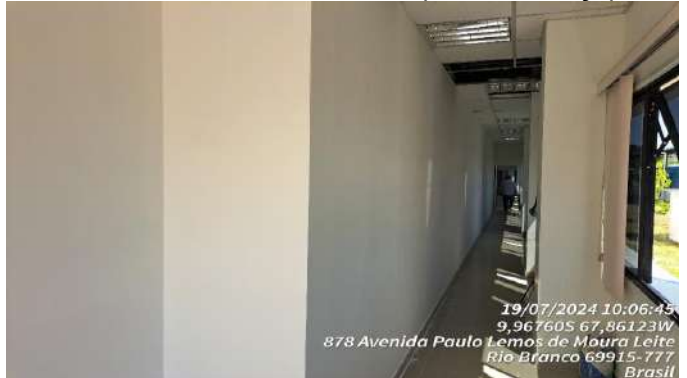
Imagem 230 EMASSAMENTO EM PAREDE
