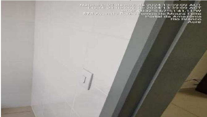
Imagem 271 INSTALAÇÃO DE INTERRUPTOR
