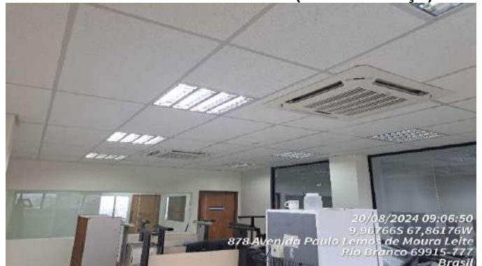
Imagem 244 FORRO DE FIBRA MINERAL
