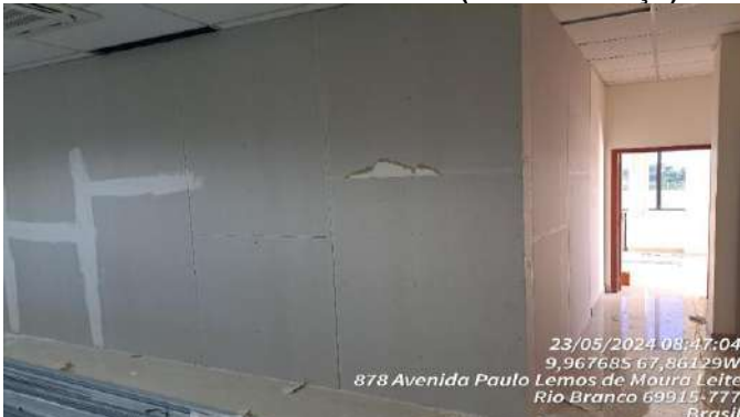
Imagem 95 PAREDES EM DRYWALL
