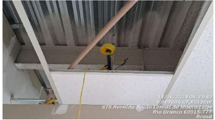
11/06/2024 08:33:42 9,96760S 67,86126W 878 Avenida Paulo Lemos de Moura Leite Rio Branco 69915-777 Brasil Imagem 248 INSTALAÇÃO DE CAIXA OCTOGONAL E CABEAMENTO ELÉTRICO
