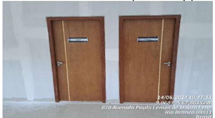
Imagem 120 REINSTALAÇÃO DE PORTA
