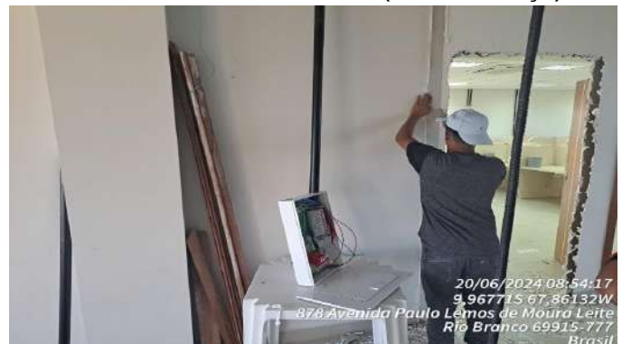
Imagem 256 INSTALAÇÃO DE QUADRO DE ENERGIA
