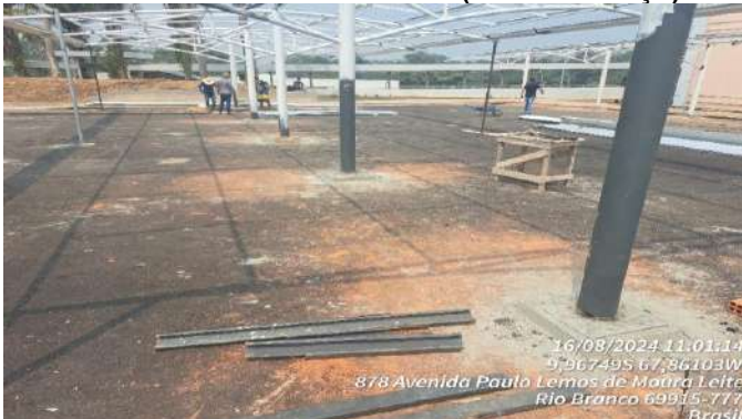
Imagem 53 ESTRUTURA METÁLICA DA COBERTURA DO ESTACIONAMENTO
