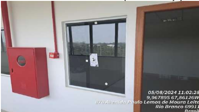
Imagem 131 INSTALAÇÃO DE VIDRO
