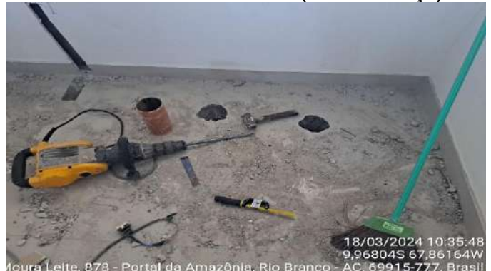
Imagem 66 DEMOLIÇÃO DE LAJE
