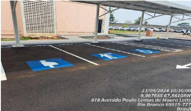
Imagem 13 PINTURA DE DEMARCAÇÃO DE VAGA E SIMBOLOS
