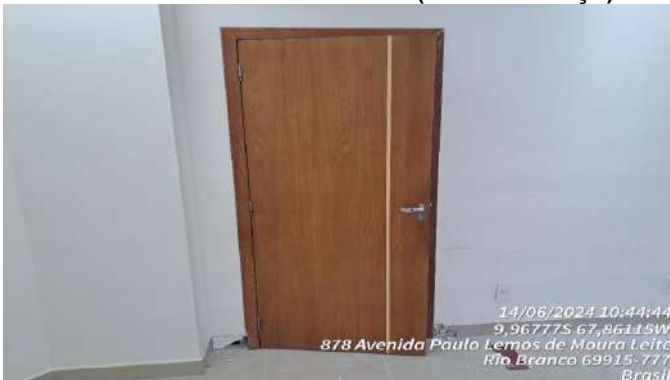
Imagem 117 REINSTALAÇÃO DE PORTA
