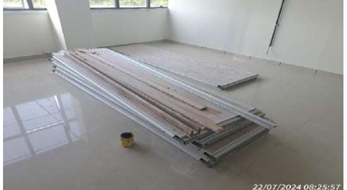
Imagem 80 REMOÇÃO DE DIVISÓRIAS EUCATEX
