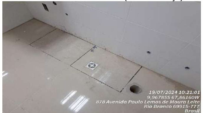
Imagem 148 REVESTIMENTO CERÂMICO DE PAREDE E DE PISO
