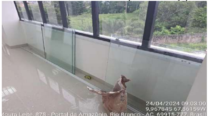
Imagem 84 REMOÇÃO DE VIDROS
