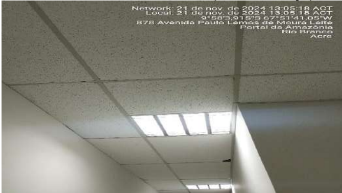
Imagem 277 INSTALAÇÃO DE LUMINÁRIAS DE LED DE EMBUTIR
