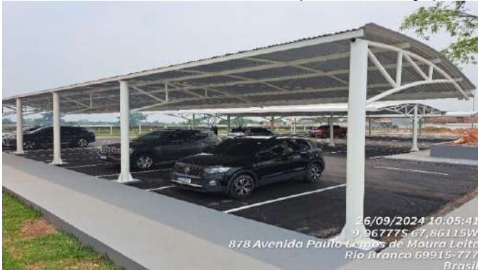
Imagem 61 COBERTURA DO ESTACIONAMENTO
