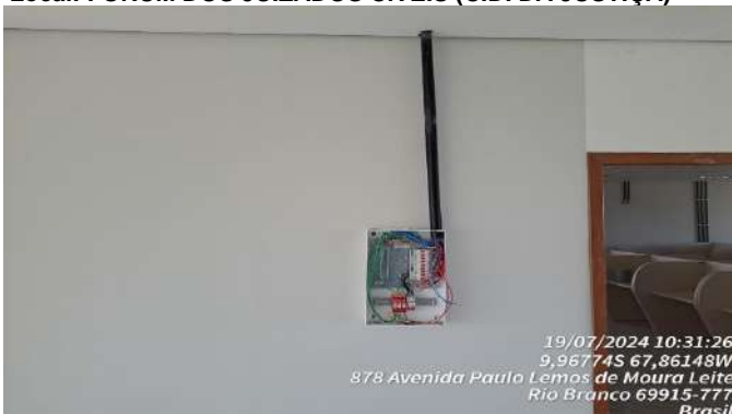
Imagem 263 INSTALAÇÃO DE QUADRO DE ENERGIA
