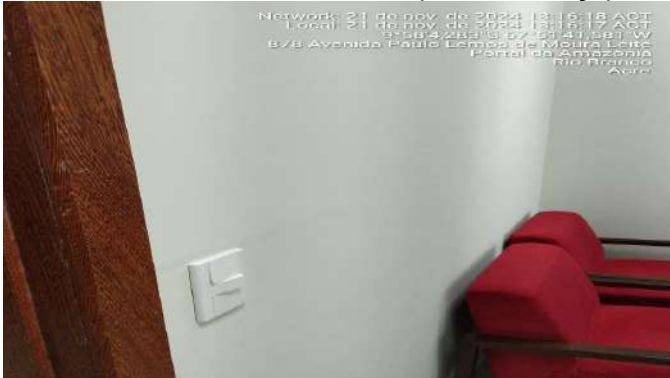
Imagem 283 INSTALAÇÃO DE INTERRUPTOR
