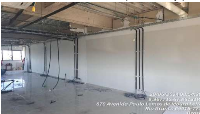
Imagem 257 INSTALAÇÃO DE CABEAMENTO DA REDE ELÉTRICA, ELETROCALHA E ELETRODUTO
