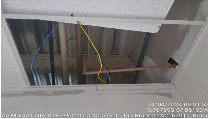
24/04/2024 09:01:52 9,96789S 67,86150W de Moura Leite, 878 - Portal da Amazônia, Rio Branco - AC, 69911, Brasil Imagem 247 INSTALAÇÃO DE CABEAMENTO DA REDE ELÉTRICA COM ELETRODUTO
