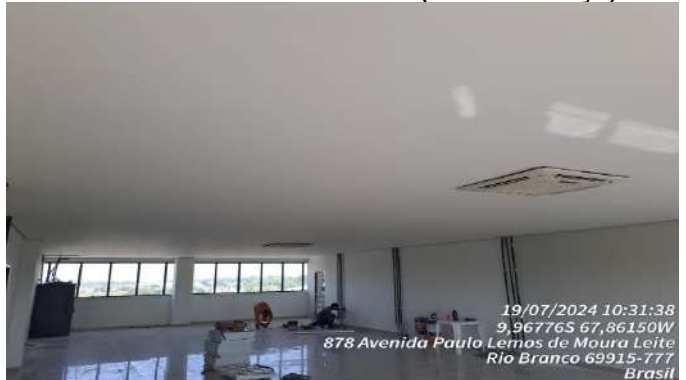
Imagem 262 INSTALAÇÃO DE PONTOS DE LÓGICA PARA LINE CORDS
