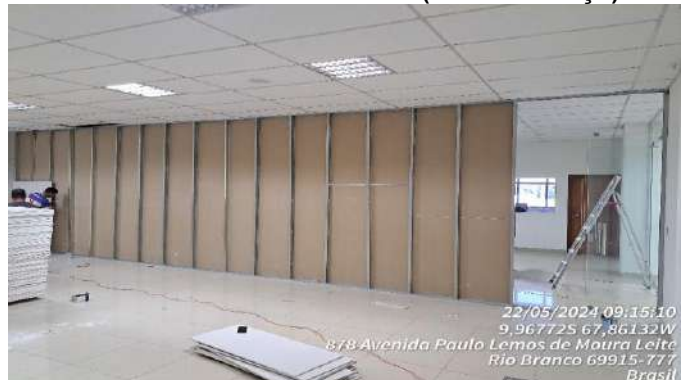
Imagem 94 PAREDES EM DRYWALL
