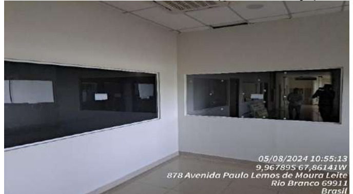
Imagem 128 INSTALAÇÃO DE VIDRO
