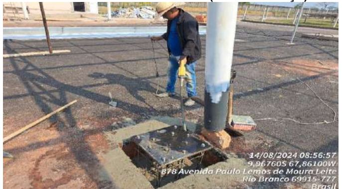
Imagem 52 CONCRETAGEM DAS FUNDAÇÕES DA ESTRUTURA METÁLICA DA COBERTURA DO ESTACIONAMENTO
