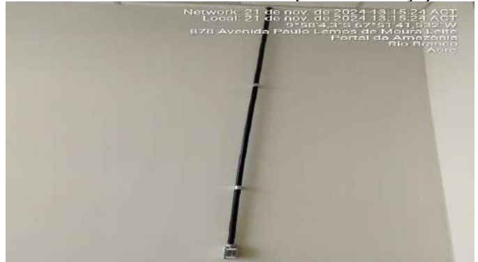
Imagem 288 INSTALAÇÃO DE PONTOS DE LÓGICA PARA LINE CORDS
