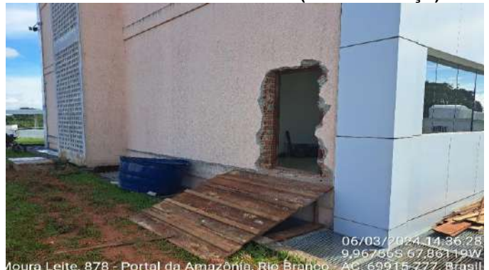
Imagem 64 DEMOLIÇÃO DE ALVENARIA
