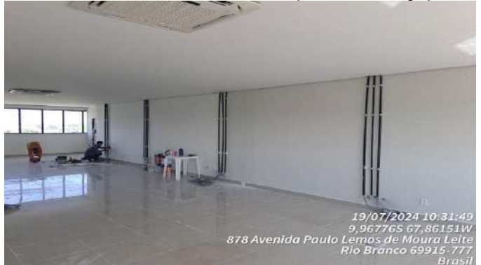
Imagem 260 INSTALAÇÃO DE PONTOS DE LÓGICA PARA LINE CORDS
