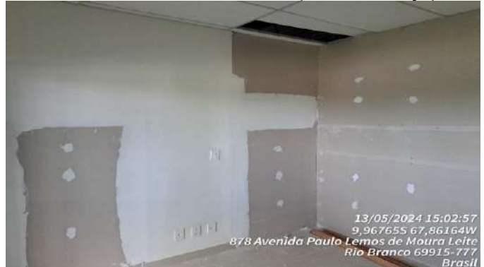
Imagem 92 PAREDES EM DRYWALL
