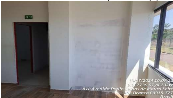
Imagem 231 EMASSAMENTO EM PAREDE
