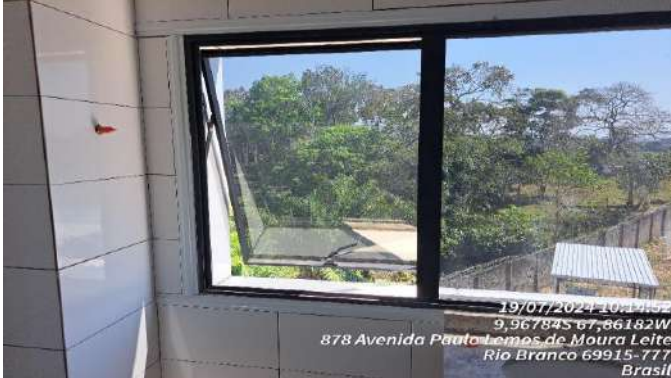
Imagem 121 REINSTALAÇÃO DE VIDRO LISO FUMÊ
