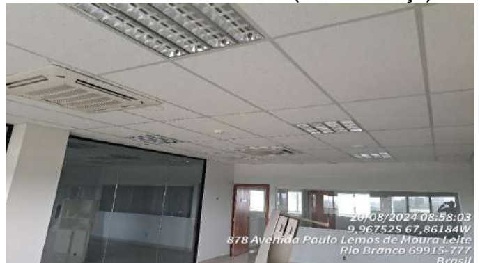
Imagem 246 FORRO DE FIBRA MINERAL
