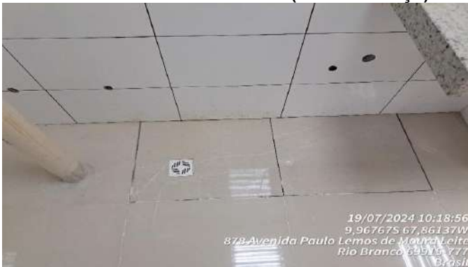
Imagem 147 REVESTIMENTO CERÂMICO DE PAREDE E DE PISO
