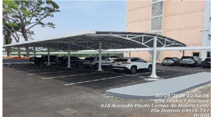
Imagem 62 COBERTURA DO ESTACIONAMENTO
