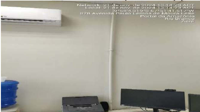
Imagem 287 INSTALAÇÃO DE PONTOS DE LÓGICA PARA LINE CORDS
