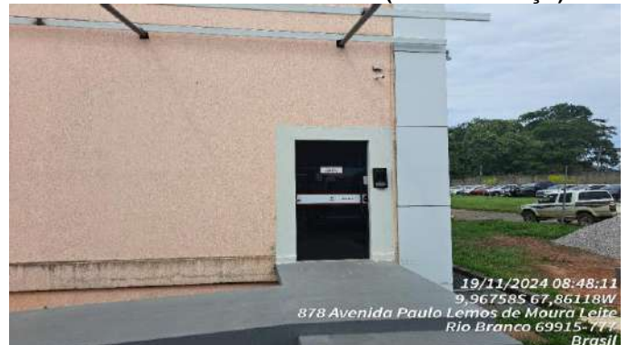
Imagem 160 INSTALAÇÃO DE PORTA DE VIDRO
