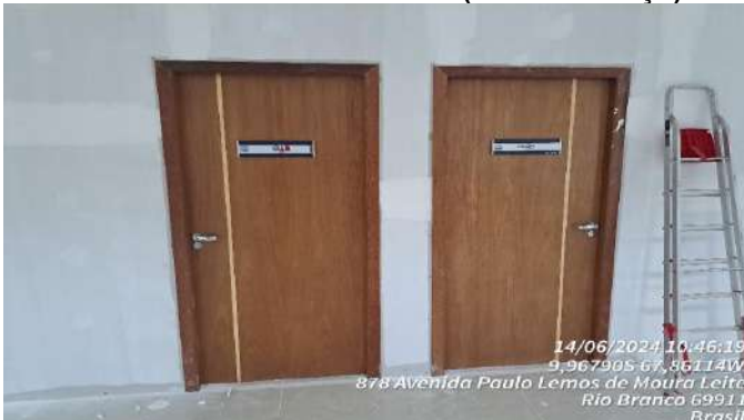
Imagem 119 REINSTALAÇÃO DE PORTA
