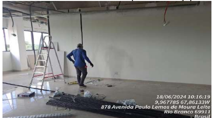
18/06/2024 10:16:19 9,96778S 67,86133W 878 Avenida Paulo Lemos de Moura Leite Rio Branco 69911 Brasil Imagem 252 PASSAGEM DE ELETRODUTO
