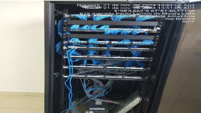
Imagem 267 INSTALAÇÃO DE PATCH PANEL, GUIA DE CABOS E PATCH CORDS
