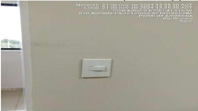
Imagem 273 INSTALAÇÃO DE INTERRUPTOR
