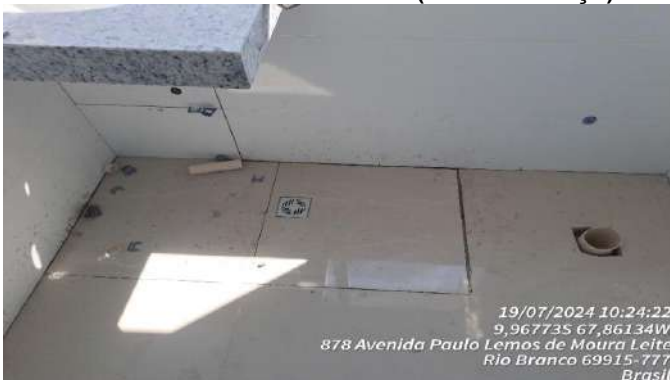
Imagem 149 REVESTIMENTO CERÂMICO DE PAREDE E DE PISO
