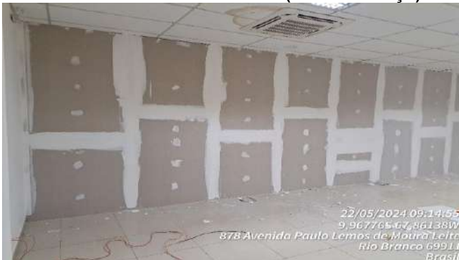
Imagem 93 PAREDES EM DRYWALL
