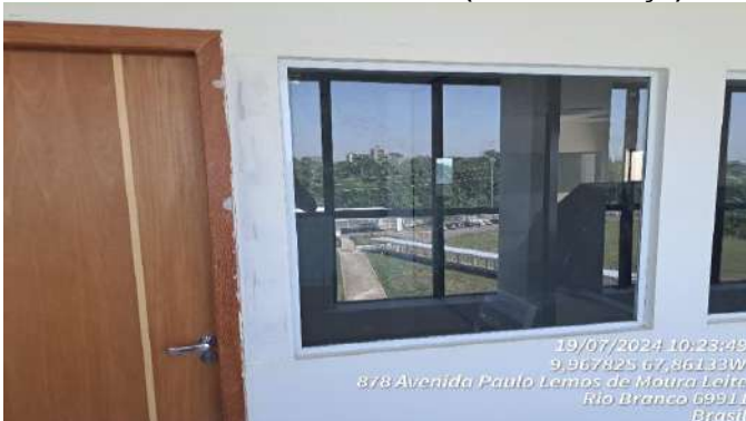
Imagem 129 INSTALAÇÃO DE VIDRO
