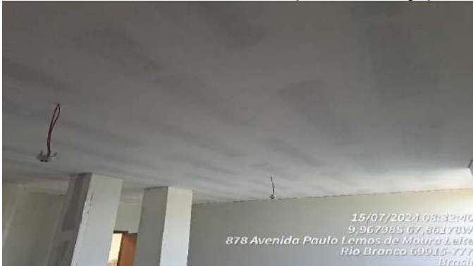
Imagem 229 SELADOR EM TETO APLICADO E EMASSAMENTO EM TETO
