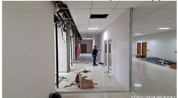
Imagem 96 PAREDES EM DRYWALL
