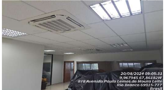
Imagem 242 FORRO DE FIBRA MINERAL
