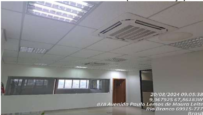
Imagem 243 FORRO DE FIBRA MINERAL
