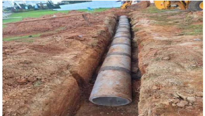
Imagem 14 ESCAVAÇÃO MECANIZADA, PREPARO DE FUNDO DE VALA, TUBO DE CONCRETO DN 400MM
