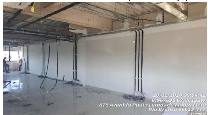
Imagem 258 INSTALAÇÃO DE CABEAMENTO DA REDE ELÉTRICA, ELETROCALHA E ELETRODUTO
