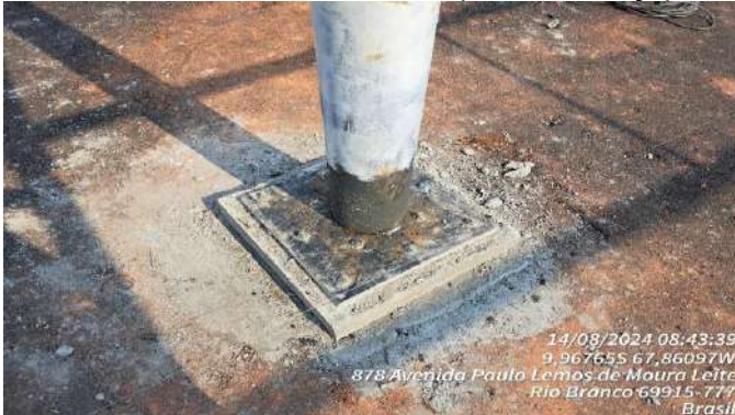
Imagem 49 ESTRUTURA METÁLICA DA COBERTURA DO ESTACIONAMENTO SOBRE BASE COM REFORÇO
