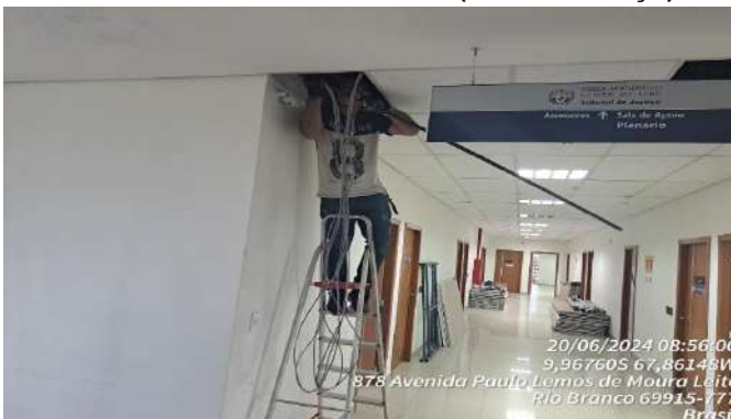
Imagem 255 INSTALAÇÃO DE ELETRODUTO E CABO DE LÓGICA
