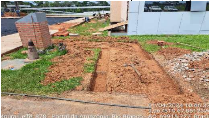
Imagem 161 ESCAVAÇÃO MANUAL PARA RAMPA DE ACESSO AO PRÉDIO
