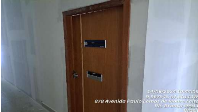
Imagem 115 REINSTALAÇÃO DE PORTA
