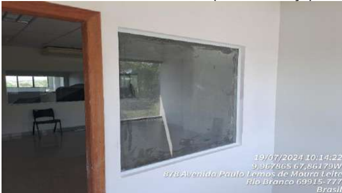
Imagem 123 REINSTALAÇÃO DE VIDRO
