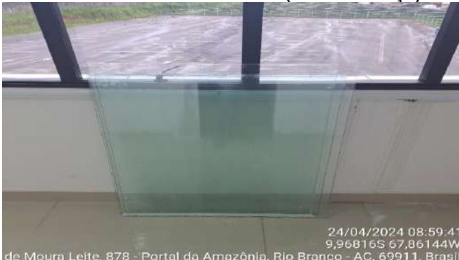
Imagem 83 REMOÇÃO DE VIDROS
