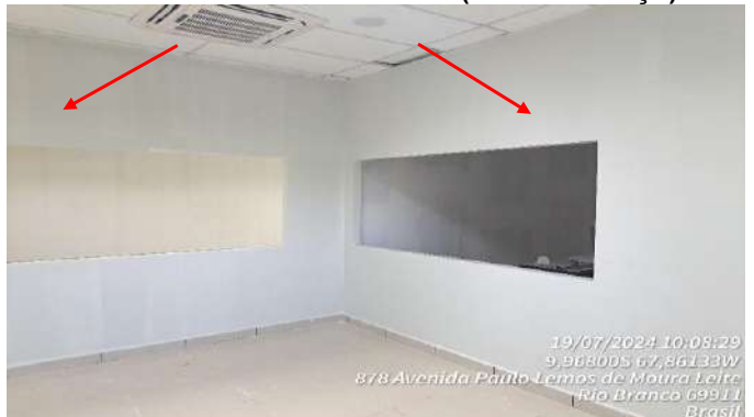
Imagem 232 EMASSAMENTO E PINTURA EM PAREDE
