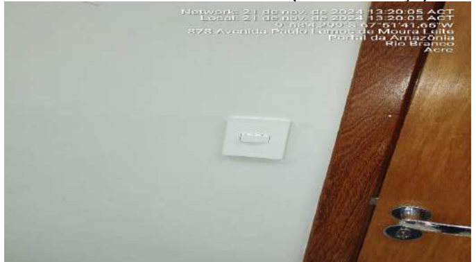
Imagem 282 INSTALAÇÃO DE INTERRUPTOR
