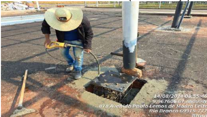
Imagem 51 CONCRETAGEM DAS FUNDAÇÕES DA ESTRUTURA METÁLICA DA COBERTURA DO ESTACIONAMENTO
