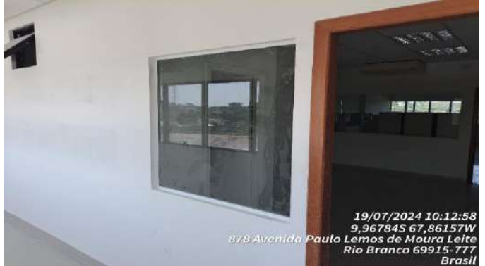
Imagem 122 REINSTALAÇÃO DE VIDRO
