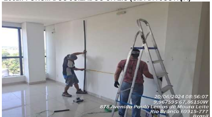
Imagem 264 INSTALAÇÃO DE PONTOS DE LÓGICA PARA LINE CORDS
