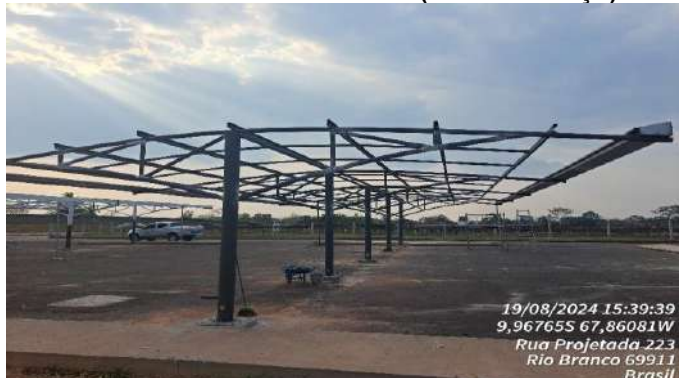
Imagem 54 ESTRUTURA METÁLICA DA COBERTURA DO ESTACIONAMENTO + CALHA
