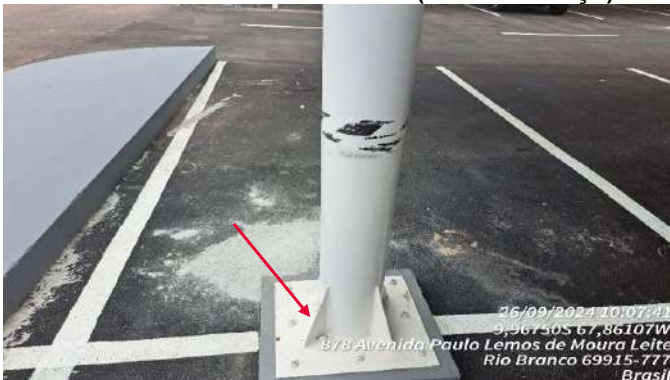
Imagem 63 ABAS DE REFORÇO EM CHAPA DE AÇO 4,75MM
