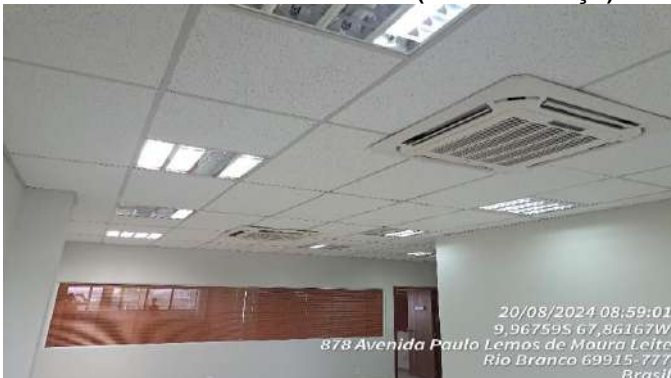
Imagem 245 FORRO DE FIBRA MINERAL
