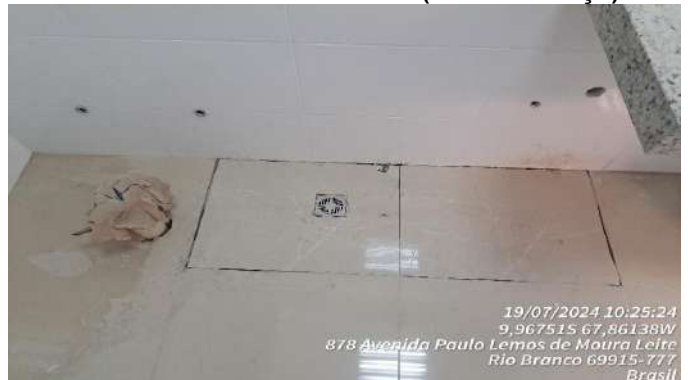
Imagem 150 DEMOLIÇÃO DE CONCRETO SIMPLES
