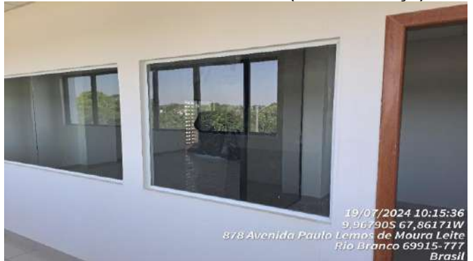
Imagem 124 REINSTALAÇÃO DE VIDRO
