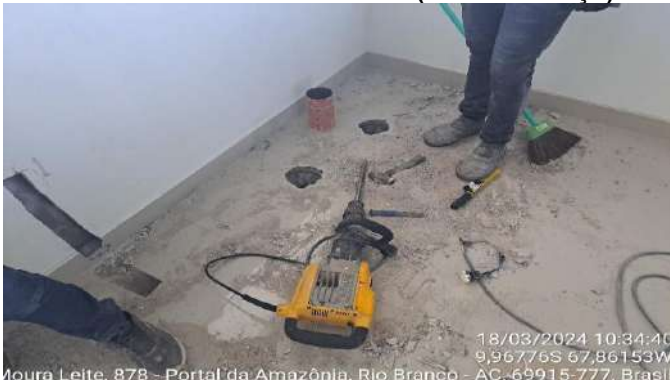
Imagem 65 DEMOLIÇÃO DE LAJE
