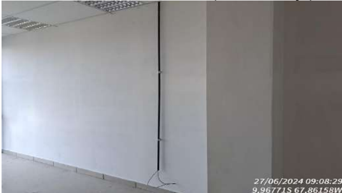
Imagem 259 INSTALAÇÃO DE PONTOS DE LÓGICA PARA LINE CORDS
