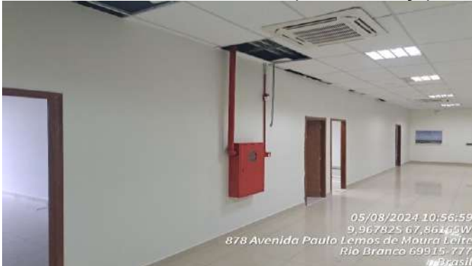
Imagem 241 RECOLOCAÇÃO DE HIDRANTE. PINTURA E RODAPÉ
