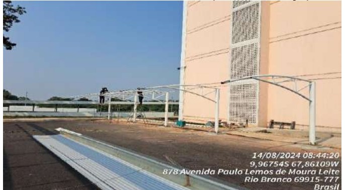
Imagem 50 ESTRUTURA METÁLICA DA COBERTURA DO ESTACIONAMENTO
