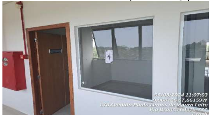
Imagem 132 INSTALAÇÃO DE VIDRO
