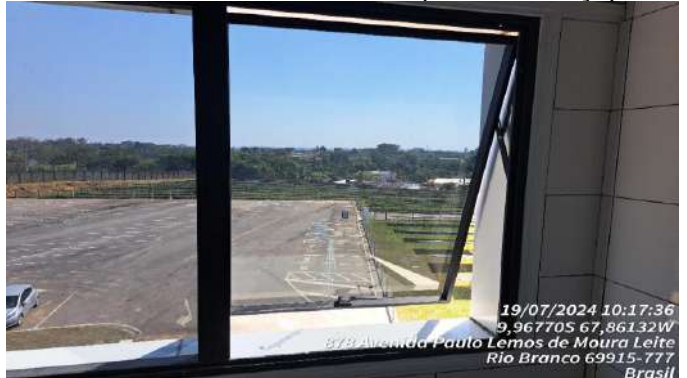
Imagem 126 REINSTALAÇÃO DE VIDRO LISO FUMÊ
