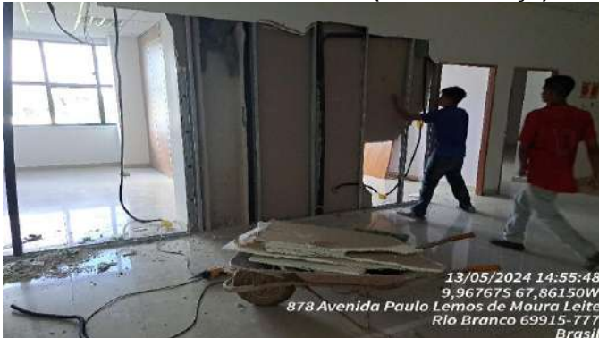
Imagem 81 REMOÇÃO DE PAREDES EM DRYWALL
