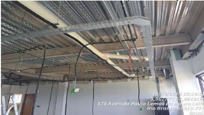
18/06/2024 10:14:51 9,96777S 67,86131W 878 Avenida Paulo Lemos de Moura Leite Rio Branco 69915-777 Brasil Imagem 249 INSTALAÇÃO DE CABEAMENTO DA REDE ELÉTRICA, ELETROCALHA E ELETRODUTO
