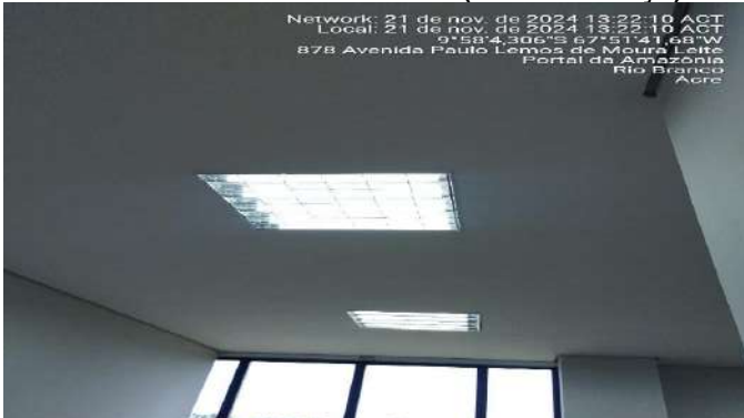
Imagem 285 INSTALAÇÃO DE LUMINÁRIAS DE LED DE EMBUTIR
