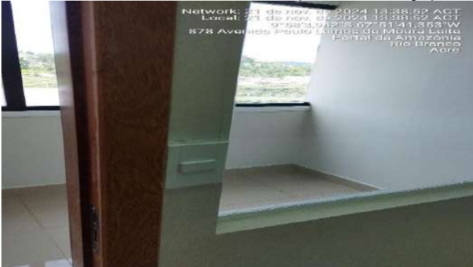
Imagem 265 INSTALAÇÃO DE INTERRUPTOR
