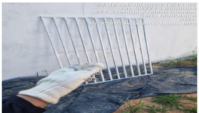
Imagem 52 PINTURA DA GRADE DE JANELA
