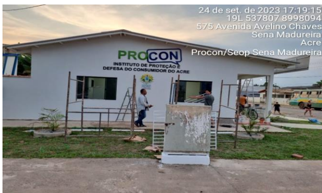
Imagem 5 UTILIZAÇÃO DE ANDAIME
