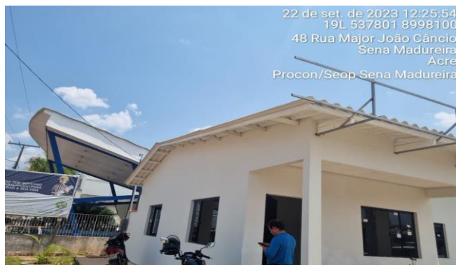
Imagem 61 METALON E PLACA CIMENTÍCIA
