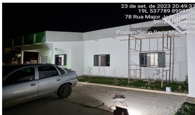
Imagem 62 METALON E PLACA CIMENTÍCIA
