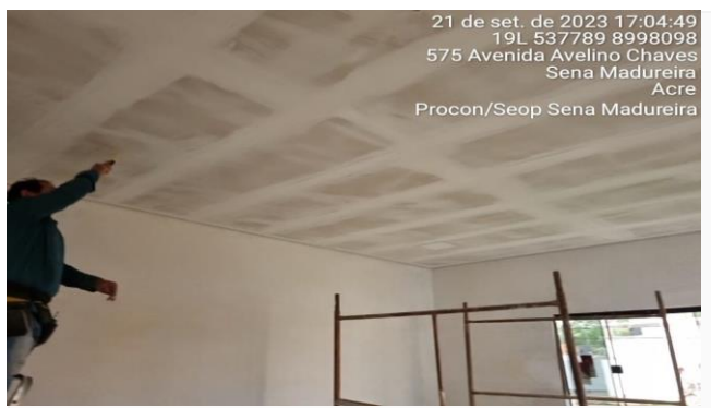
Imagem 33 FORRO DE GESSO
