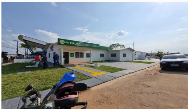
Imagem 55 PINTURA DO PATIO
