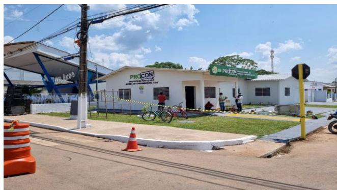
Imagem 53 PINTURA - PRÉDIO FINALIZADO
