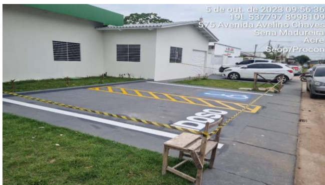
Imagem 56 PINTURA DO PATIO
