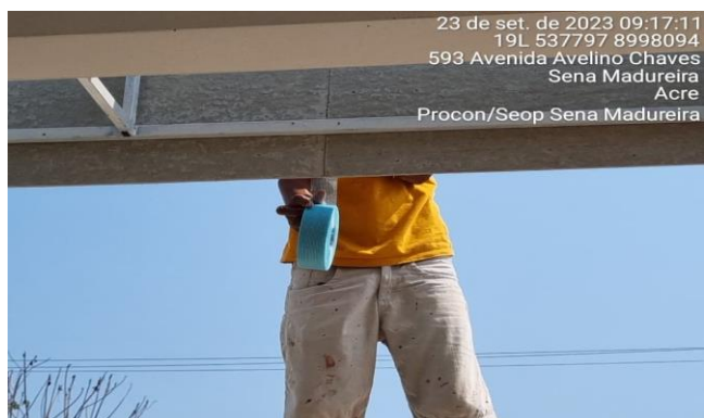
Imagem 4 UTILIZAÇÃO DE ANDAIME
