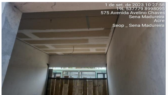
Imagem 32 FORRO DE GESSO
