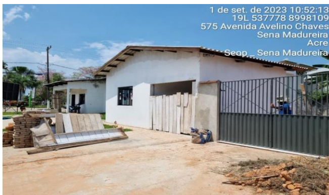
Imagem 1 EXECUÇÃO DE ALVENARIA AO LADO DO PORTÃO
