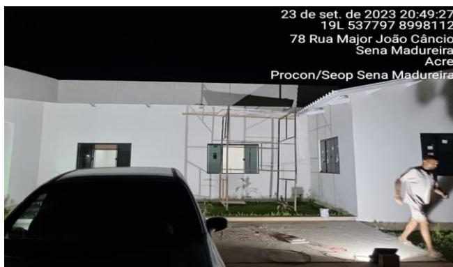
Imagem 61 METALON E PLACA CIMENTÍCIA
