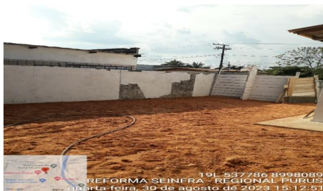
Imagem 54 PINTURA DO MURO - CAIAÇÃO
