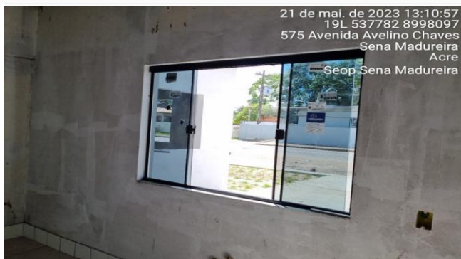
Imagem 51 PINTURA DO PRÉDIO
