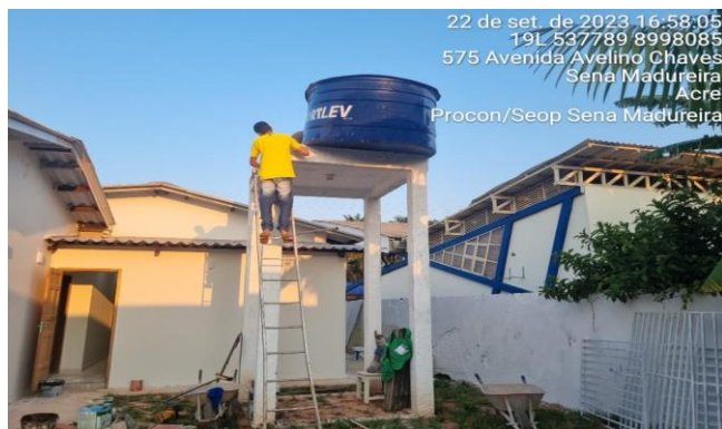
Imagem 10 INSTALAÇÃO DE CAIXA DE ÁGUA
