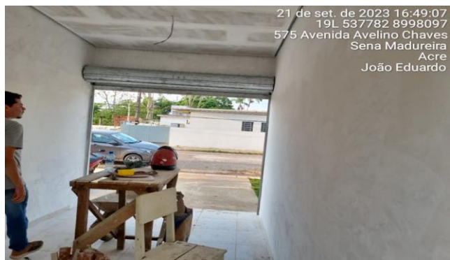
Imagem 33 FORRO DE GESSO
