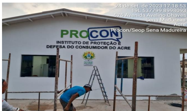
Imagem 6 UTILIZAÇÃO DE ANDAIME
