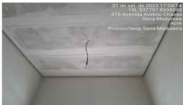
Imagem 34 FORRO DE GESSO
