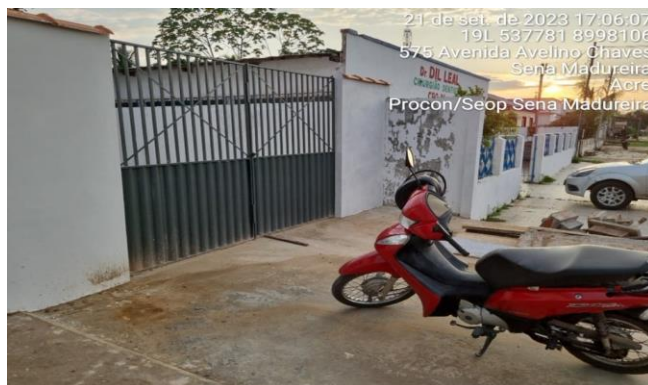
Imagem 2 EXECUÇÃO DE ALVENARIA AO LADO DO PORTÃO
