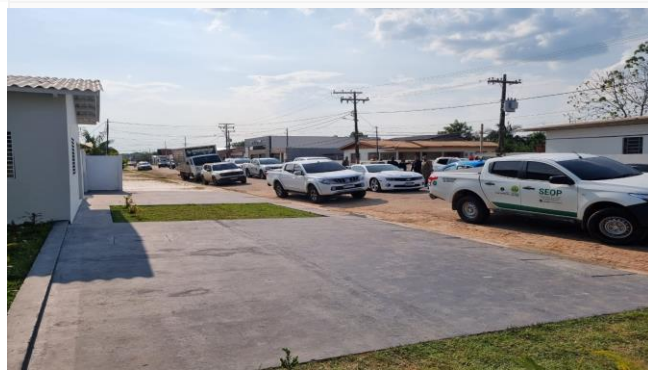
Imagem 56 PINTURA DO PATIO
