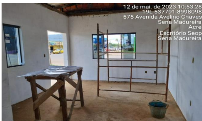
Imagem 3 UTILIZAÇÃO DE ANDAIME
