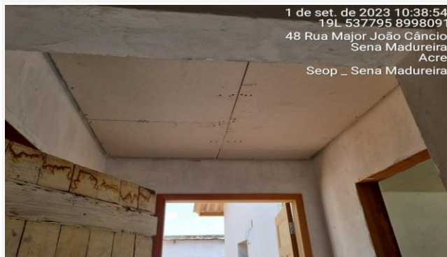
Imagem 32 FORRO DE GESSO
