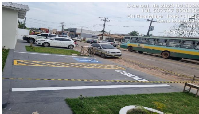
Imagem 57 PINTURA DO PATIO
