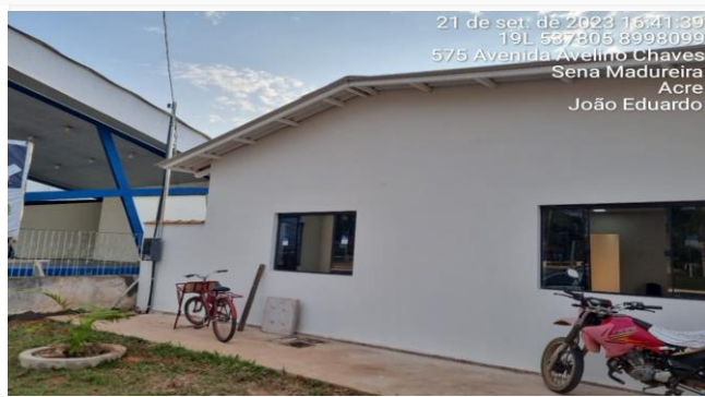
Imagem 52 PINTURA DO PRÉDIO
