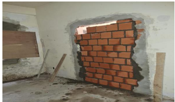
Imagem 6 Alvenaria de vedação portas no subsolo
