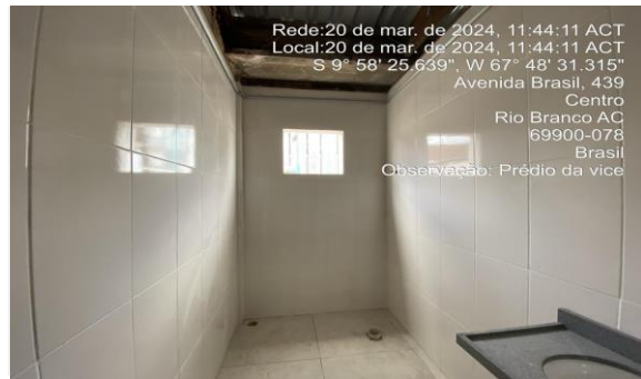
Imagem 24 Execução do revestimento cerâmico de paredes e piso (WC PNE)
