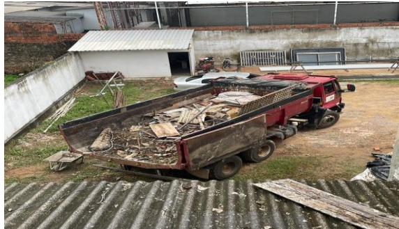
Imagem 38 Entulho das demolições
