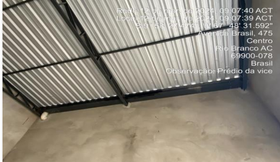
Imagem 61 Execução da nova cobertura da garagem da vice
