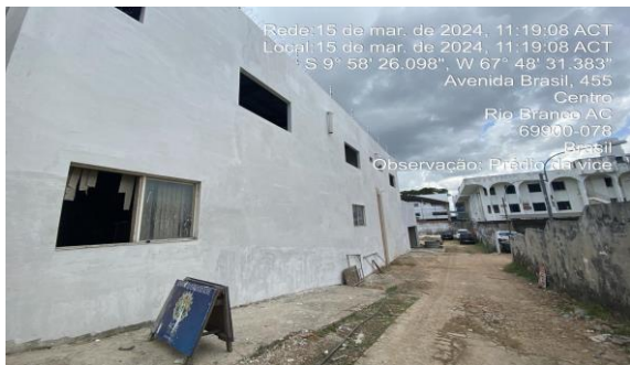
Imagem 57 Aplicação e lixamento de massa látex
