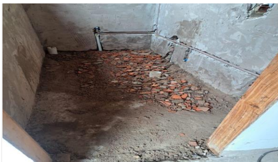
Imagem 67 Execução de instalação hidrossanitária no WC do depto. de articulação
