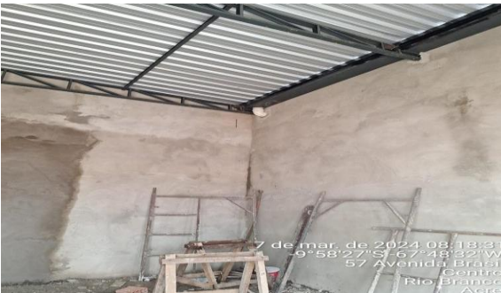
Imagem 63 Execução da nova cobertura da garagem da vice
