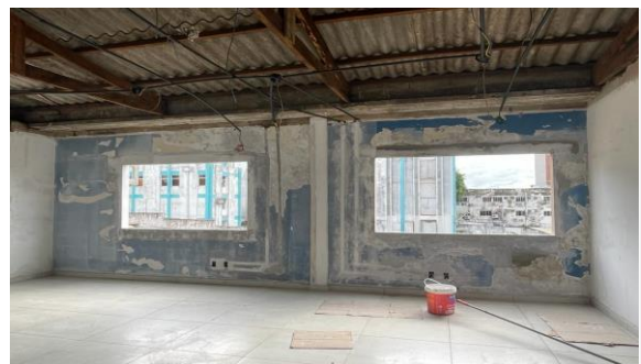
Imagem 60 Aplicação de massa acrílica em paredes internas
