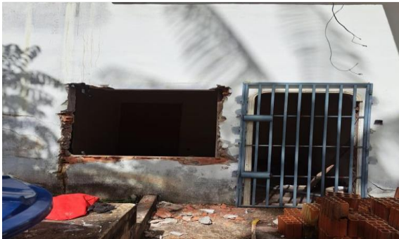
Imagem 3 Janelas do subsolo antes da alvenaria de vedação
