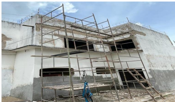
Imagem 53 Aplicação e lixamento de massa látex
