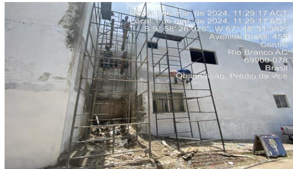
Imagem 52 Aplicação e lixamento de massa látex
