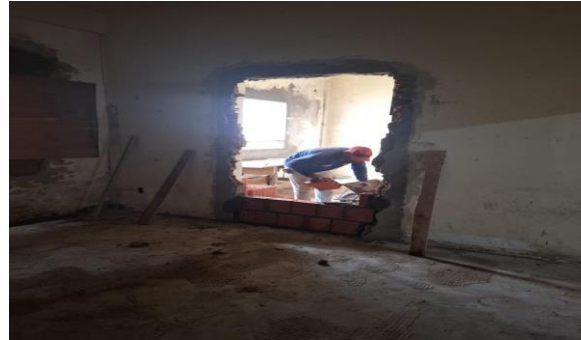
Imagem 4 Alvenaria de vedação nas portas no subsolo
