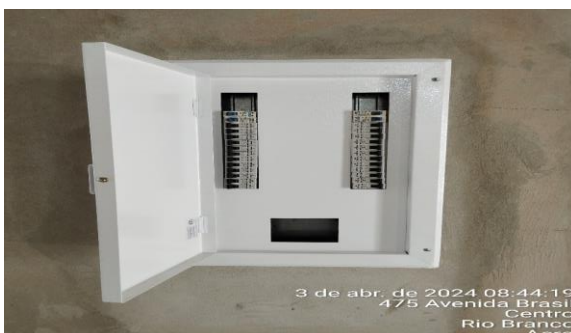
Imagem 71 Instalação de Quadro de Distribuição de energia de 150 A
