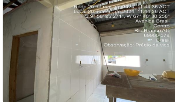
Imagem 20 Execução do revestimento cerâmico de paredes (copa)
