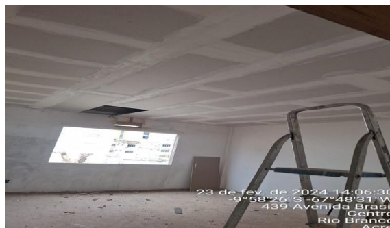
Imagem 70 Execução de forro drywall
