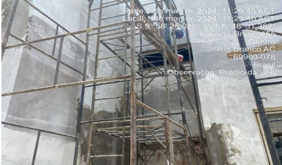
Imagem 49 Aplicação e lixamento de massa látex
