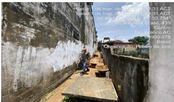
Imagem 41 Execução das caixas da rede de drenagem e esgoto
