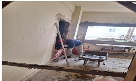
Imagem 5 Alvenaria de vedação portas no subsolo
