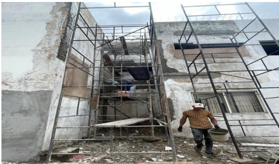
Imagem 51 Aplicação e lixamento de massa látex
