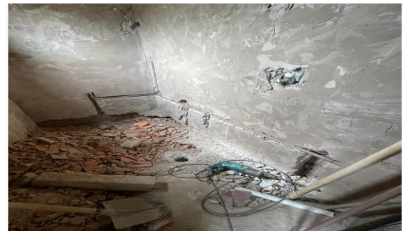
Imagem 66 Execução de instalação hidrossanitária no WC do depto.
