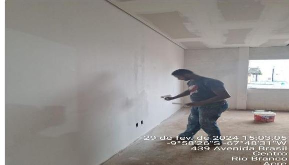
Imagem 64 Aplicação de massa acrílica em paredes internas
