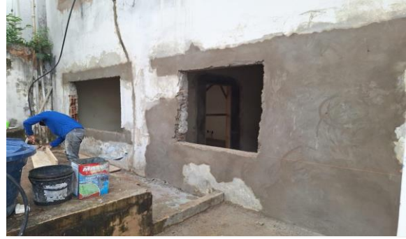
Imagem 2 Alvenaria de vedação nas janelas no subsolo
