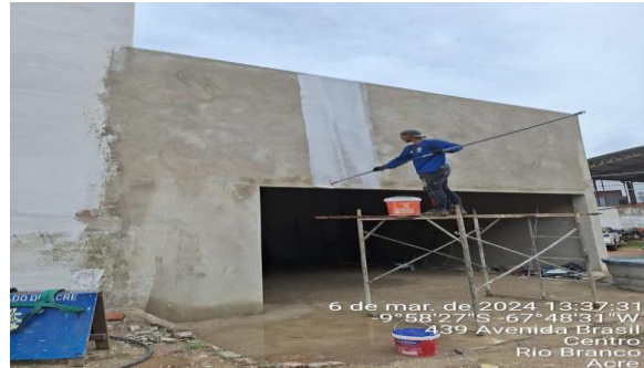
Imagem 56 Aplicação de selador nas paredes externas
