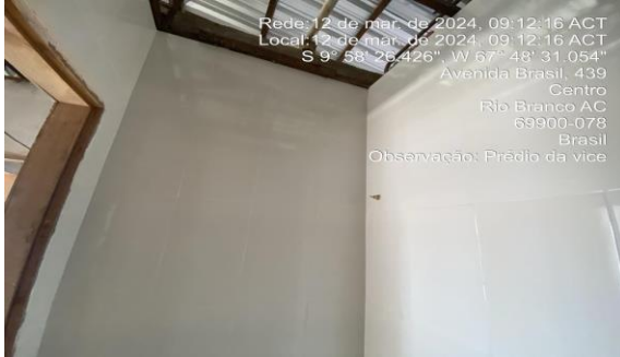
Imagem 19 Execução do revestimento cerâmico de paredes (WC do corredor)
