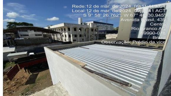
Imagem 62 Execução da nova cobertura da garagem da vice
