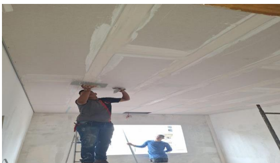
Imagem 69 Execução de forro drywall
