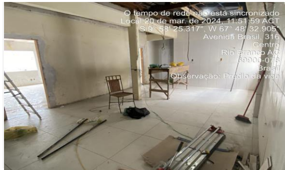
Imagem 21 Execução do revestimento cerâmico de paredes e piso (copa)
