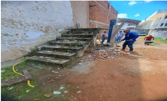
Imagem 1 Demolição da escada ao lado da rampa de acesso para o estacionamento
