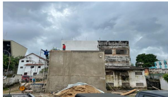
Imagem 54 Aplicação e lixamento de massa látex
