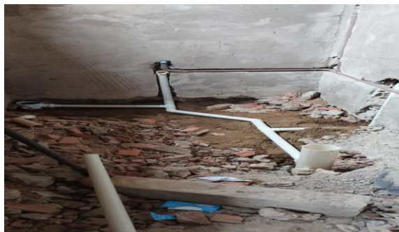
Imagem 40 Execução de instalações hidrossanitárias
