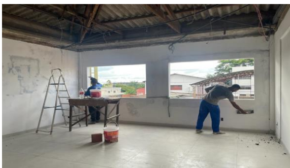
Imagem 59 Aplicação de selador acrílico em paredes internas
