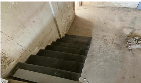
Imagem 65 Execução da aplicação do piso nos degraus da escada
