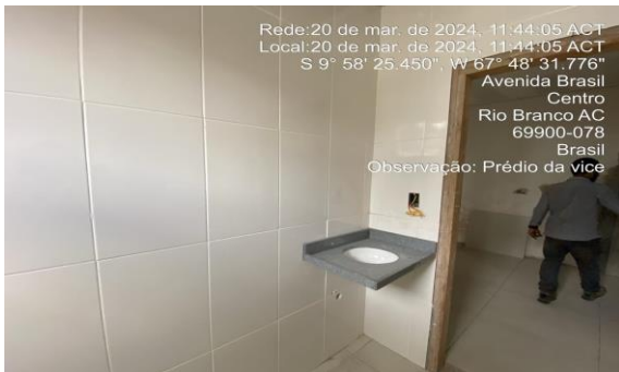
Imagem 23 Fixação das bancadas dos WCs (WC PNE)
