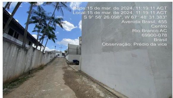
Imagem 58 Aplicação e lixamento de massa látex
