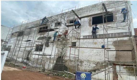
Imagem 55 Remoção de pintura de paredes externas e execução de massa única
