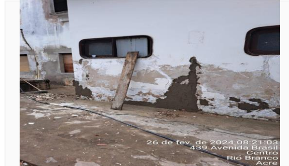
Imagem 50 Aplicação e lixamento de massa látex
