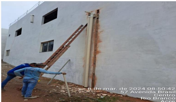
Imagem 37 Execução dos ramais de descarga
