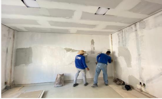
Imagem 67 Emassamento nas salas do subsolo
