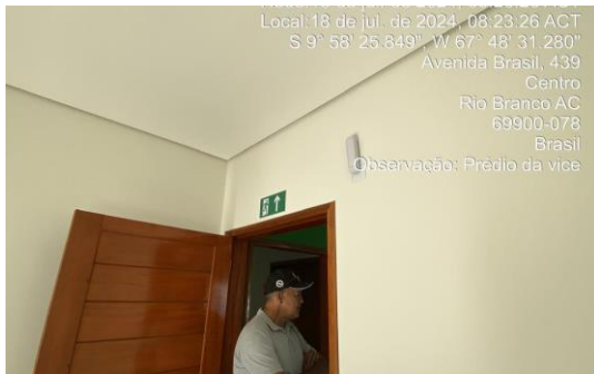
Imagem 87 Instalação das placas de sinalização e luminária de emergência, itens 20.18.1 e 15.3
