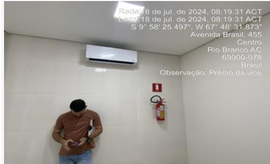
Imagem 70 Instalação dos extintores item 15.1
