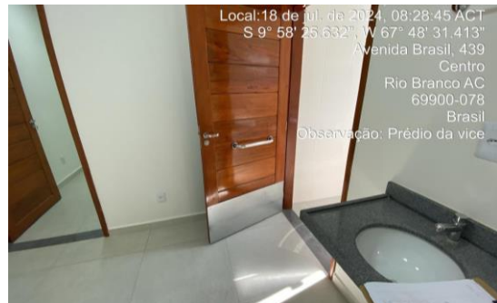
Imagem 106 Barras de acessibilidade no WC acessível
