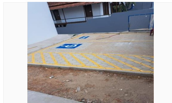
Imagem 30 Execução da pintura de demarcação de vagas nas vagas em frente ao prédio
