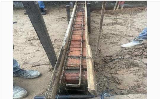
Imagem 34 Execução das 2 brocas e viga para a entrada do estacionamento da vice
