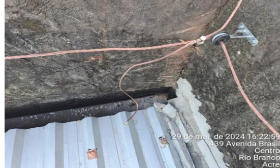
Imagem 158 Instalação da cordoalha de 35mm do spda e terminal aéreo
