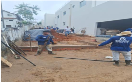
Imagem 33 Execução das 2 brocas e viga para a entrada do estacionamento da vice
