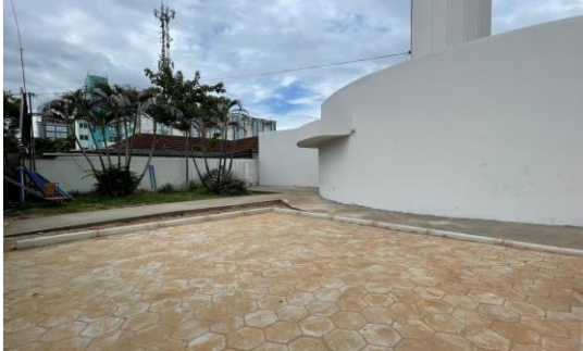
Imagem 25 Execução da calçada frontal
