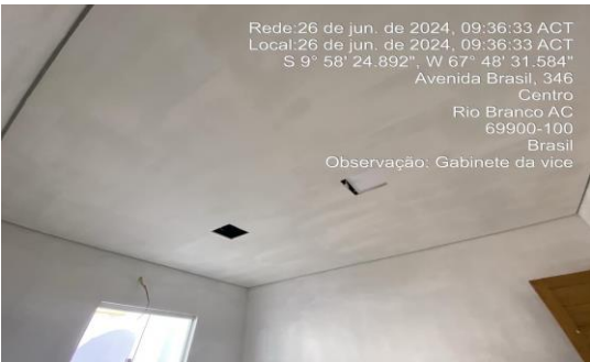
Imagem 65 Instalação do forro no subsolo
