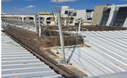
Imagem 157 Instalação do captor Franklin
