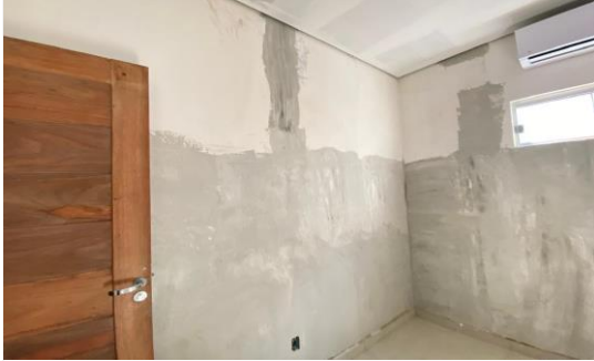
Imagem 61 Emassamento nas salas do subsolo
