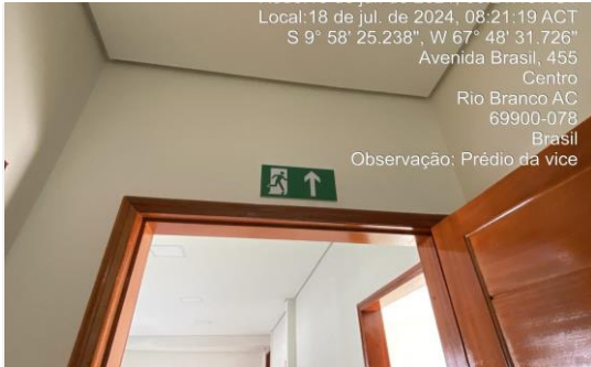
Imagem 85 Instalação das placas de sinalização, item 20.18.1
