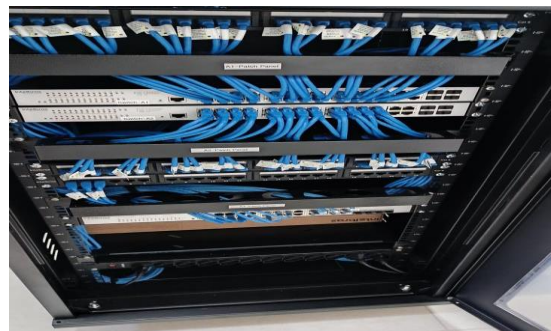
Imagem 162 Instalação do rack de rede lógica do 1º piso
