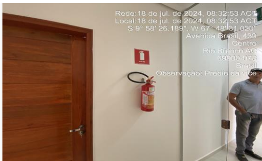
Imagem 71 Instalação dos extintores item 15.1
