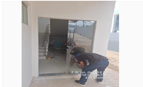
Imagem 12 Instalação porta da entrada do subsolo, 2 folhas, de vidro
