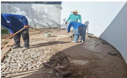
Imagem 29 Demolição de alvenaria para execução da calçada na entrada do prédio
