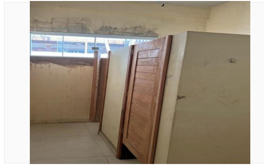
Imagem 22 Troca da porta de madeira do banheiro do subsolo
