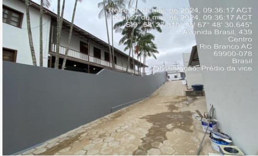
Imagem 19 Pintura do muro externo
