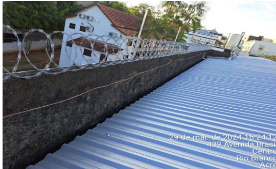
Imagem 159 Instalação da cordoalha de 35mm do spda e terminal aéreo
