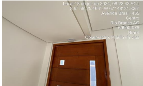
Imagem 86 Instalação de luminária de emergência, item 15.3
