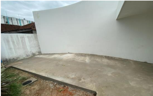
Imagem 9 Execução de calçada em frente ao prédio
