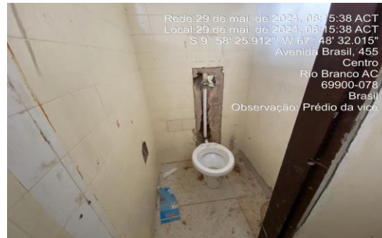
Imagem 4 Instalação hidrossanitária dos banheiros do subsolo
