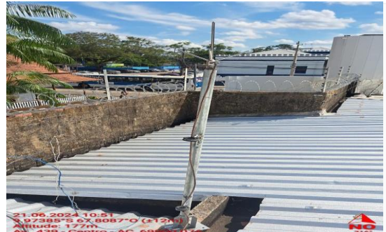
Imagem 160 Instalação do captor Franklin
