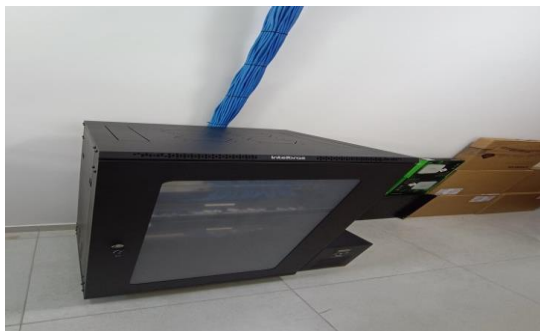
Imagem 161 Instalação do rack de rede lógica do 1º piso
