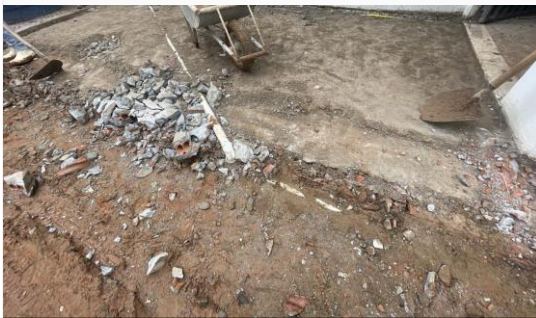
Imagem 27 Demolição de alvenaria para execução da calçada na entrada do prédio
