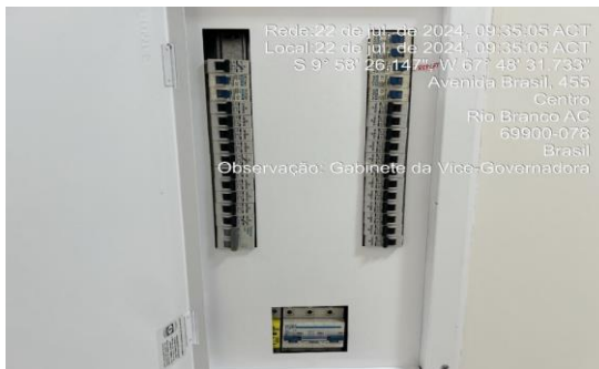
Imagem 167 Instalação do quadro de energia 1º piso
