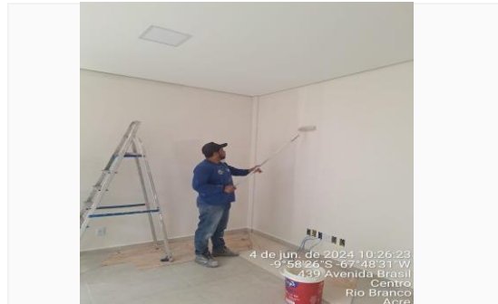
Imagem 10 Execução de pintura
