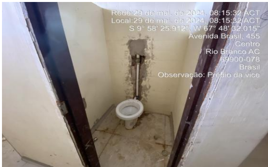
Imagem 3 Instalação hidrossanitária dos banheiros do subsolo
