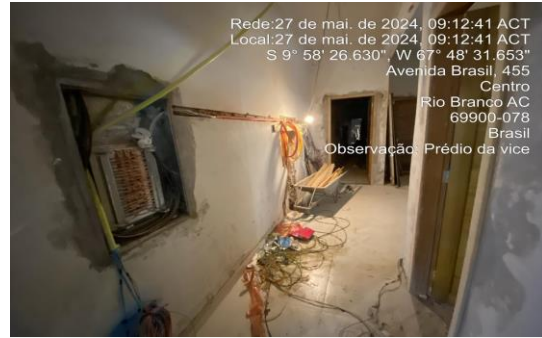
Imagem 2 Execução de rasgos para passagem de eletroduto
