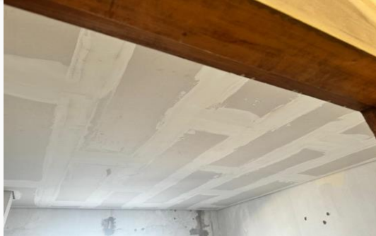
Imagem 7 Execução do forro de gesso no subsolo
