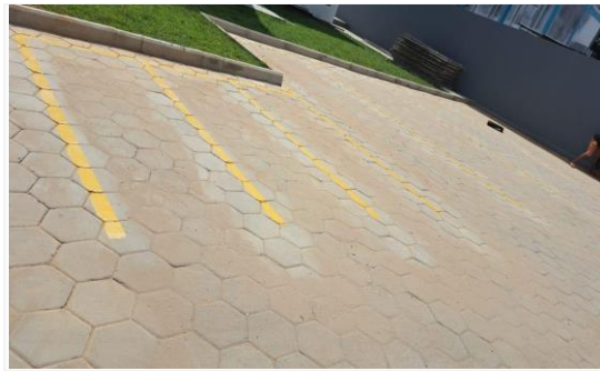
Imagem 36 Execução da pintura de demarcação de vagas no estacionamento
