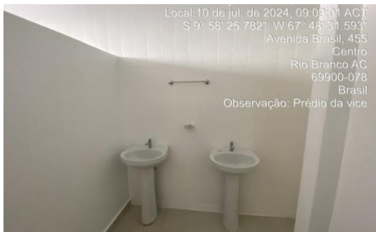
Imagem 107 Instalação do lavatório no WC feminino do subsolo
