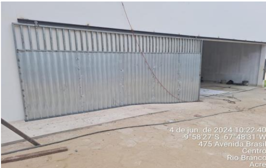
Imagem 11 Instalação do portão da garagem da vice
