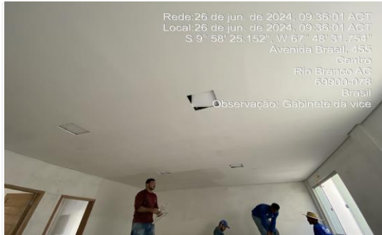
Imagem 63 Instalação do forro no subsolo
