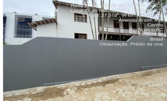
Imagem 20 Pintura do muro externo
