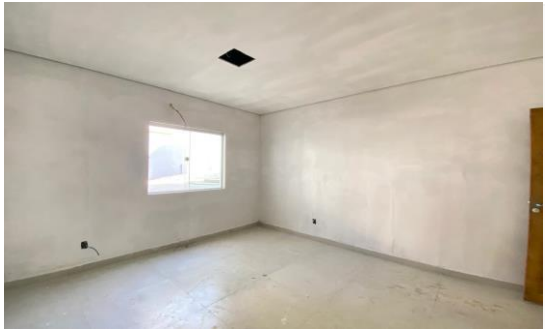
Imagem 64 Emassamento nas salas do subsolo
