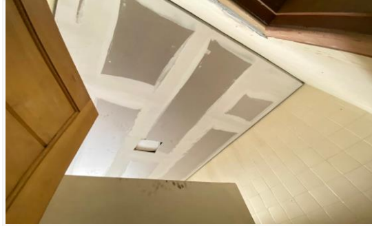
Imagem 68 Instalação do forro nos banheiros do subsolo
