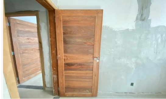
Imagem 62 Emassamento nas salas do subsolo
