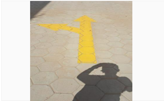
Imagem 39 Execução da pintura de demarcação de vagas no estacionamento
