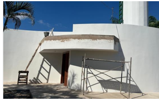
Imagem 24 Execução da alvenaria de vedação na marquise da entrada
