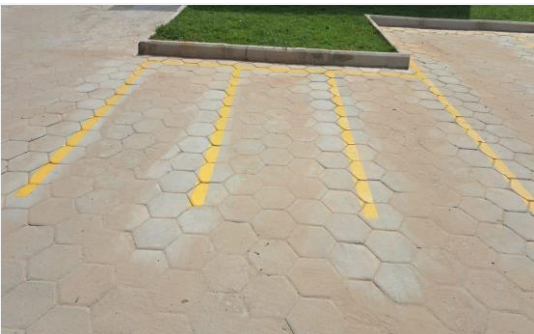
Imagem 35 Execução da pintura de demarcação de vagas no estacionamento
