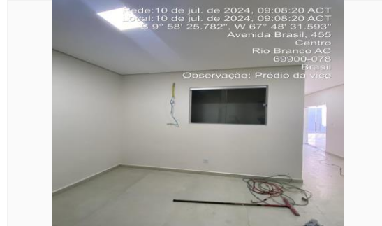
Imagem 26 J2 foi realocada para a parede onde foi feita a alvenaria de vedação do ar
