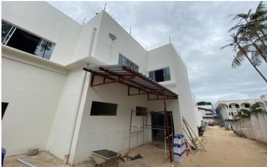
Imagem 21 Execução cobertura em frente a entrada
