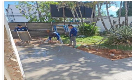
Imagem 28 Execução da calçada na entrada do prédio
