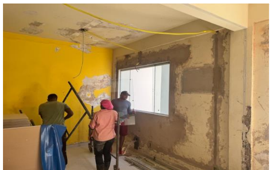
Imagem 5 Passagem de eletroduto
