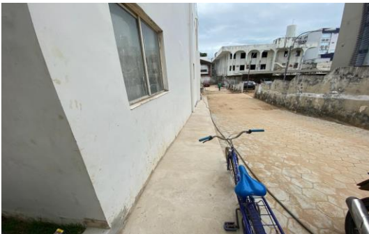
Imagem 23 Execução da calçada de entorno
