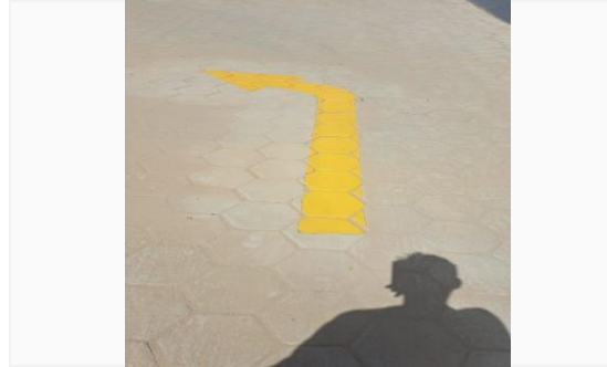
Imagem 38 Execução da pintura de demarcação de vagas no estacionamento
