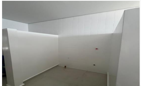
Imagem 40 Instalação hidrossanitária dos banheiros do subsolo
