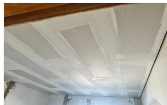
Imagem 6 Execução do forro de gesso no subsolo
