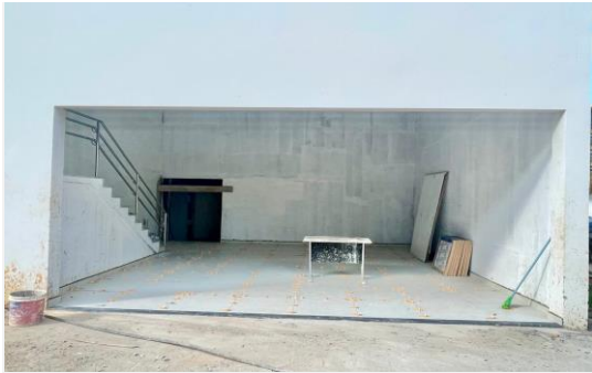
Imagem 1 Instalação soleira da garagem
