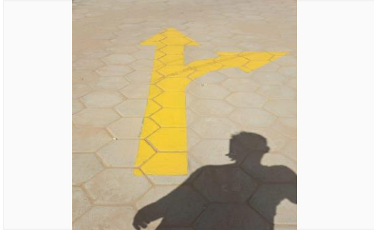
Imagem 37 Execução da pintura de demarcação de vagas no estacionamento
