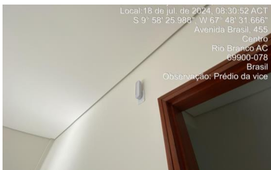
Imagem 89 Instalação de luminária de emergência, item 15.3
