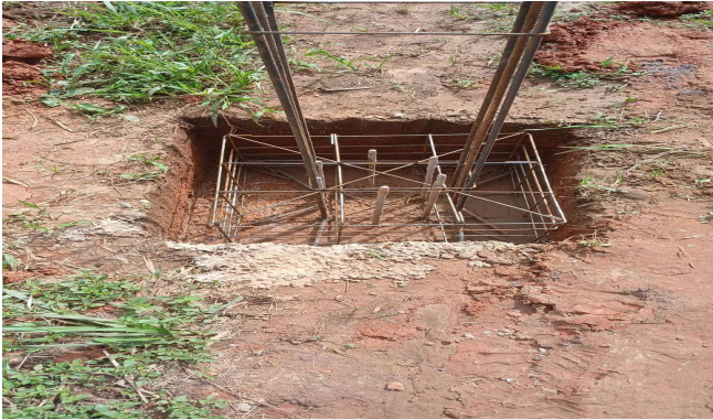
Imagem 19 Execução de blocos de concreto
