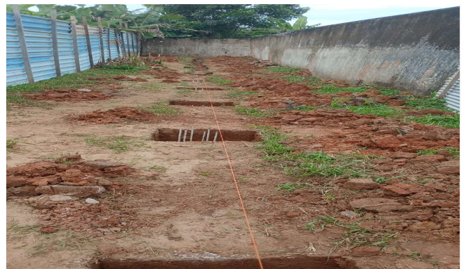
Imagem 6 Execução das brocas de concreto
