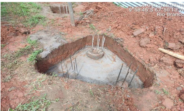
Imagem 11 Execução de blocos de concreto
