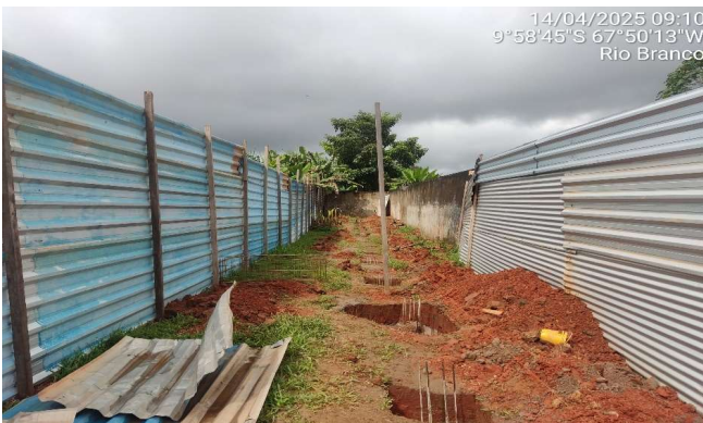
Imagem 9 Execução das brocas de concreto
