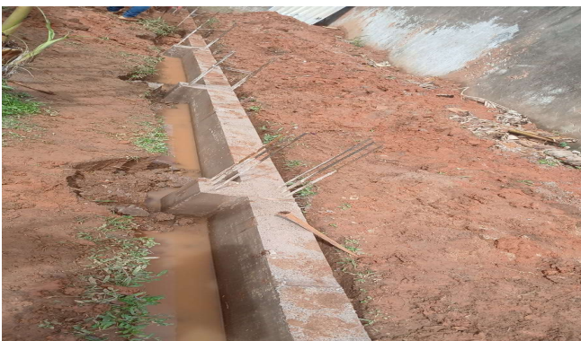
Imagem 29 Execução de viga baldrame
