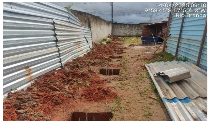
Imagem 10 Execução das brocas de concreto
