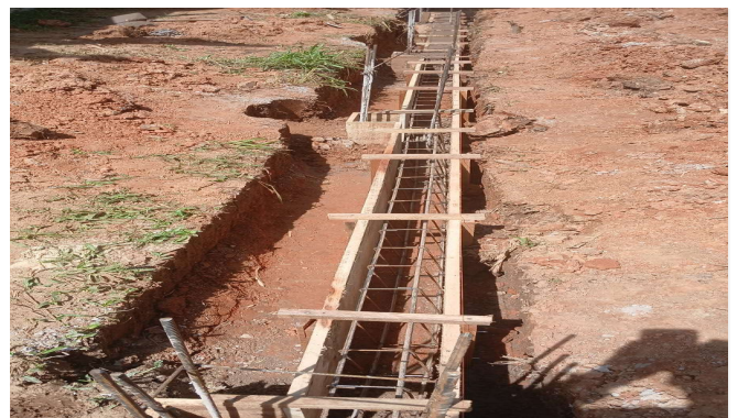
Imagem 24 Execução de viga baldrame
