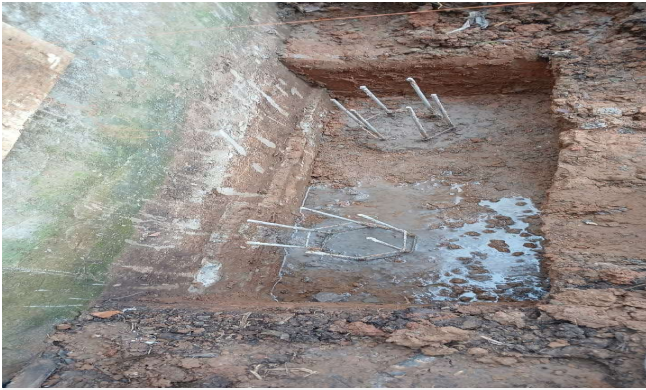
Imagem 7 Execução das brocas de concreto
