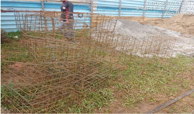
Imagem 13 Execução de blocos de concreto
