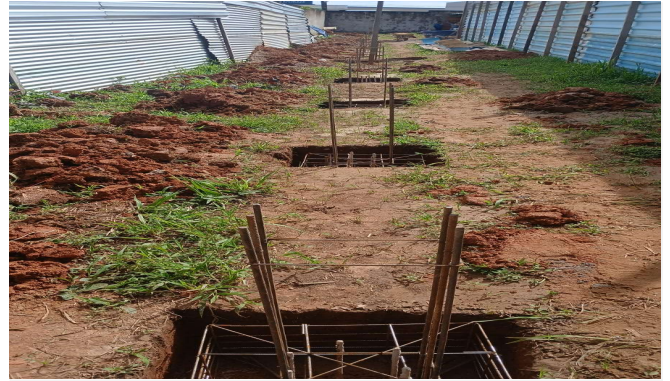
Imagem 20 Execução de blocos de concreto
