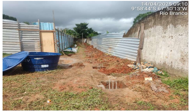
Imagem 8 Execução das brocas de concreto
