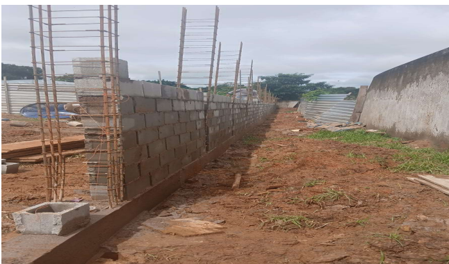
Imagem 35 Execução de alvenaria de vedação de blocos vazados de concreto
