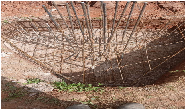
Imagem 21 Execução de blocos de concreto
