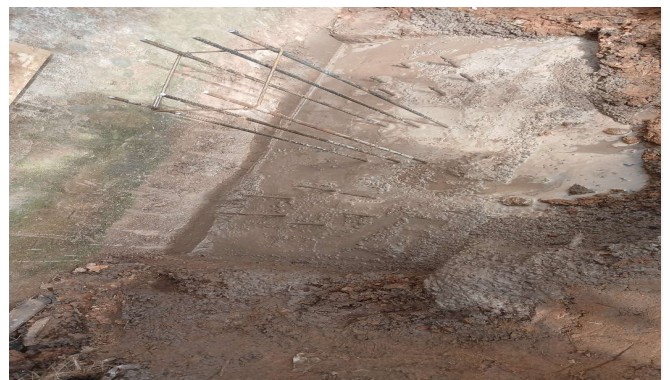
Imagem 18 Execução de blocos de concreto
