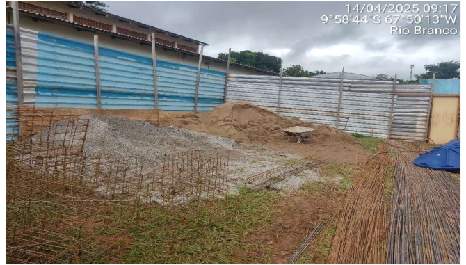
Imagem 14 Execução de blocos de concreto
