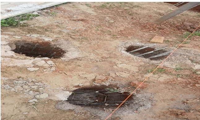
Imagem 5 Execução das brocas de concreto
