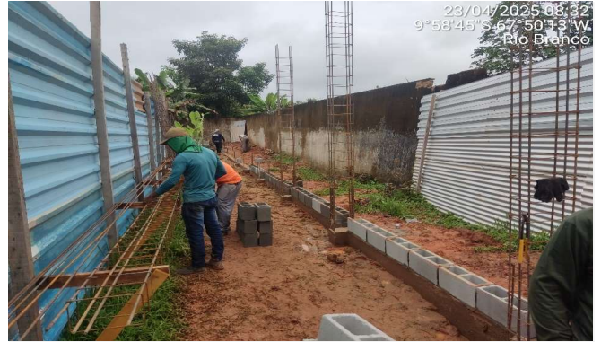
Imagem 32 Execução de alvenaria de vedação de blocos vazados de concreto
