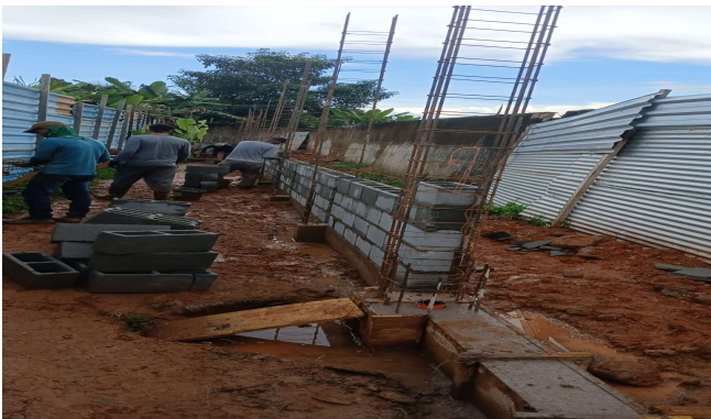
Imagem 33 Execução de alvenaria de vedação de blocos vazados de concreto
