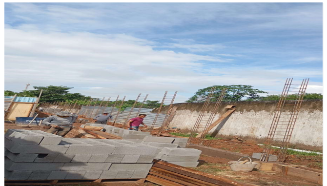
Imagem 34 Execução de alvenaria de vedação de blocos vazados de concreto
