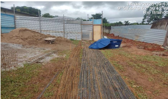
Imagem 15 Execução de blocos de concreto
