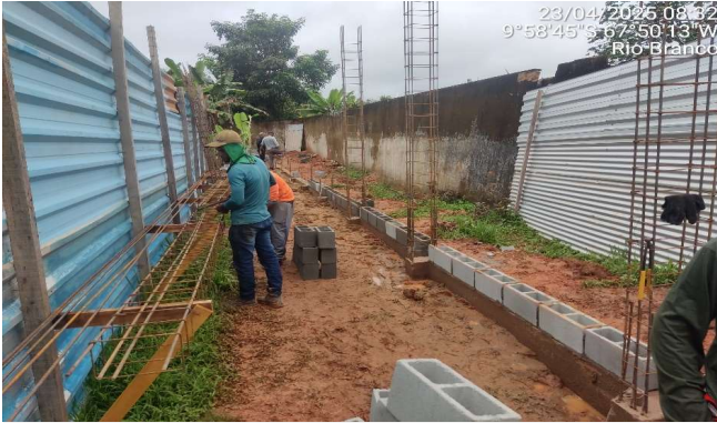
Imagem 31 Execução de alvenaria de vedação de blocos vazados de concreto
