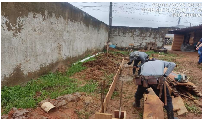
Imagem 27 Execução de viga baldrame
