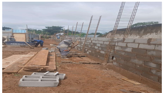
Imagem 36 Execução de alvenaria de vedação de blocos vazados de concreto
