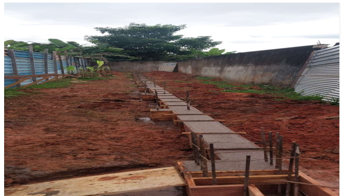
Imagem 28 Execução de viga baldrame
