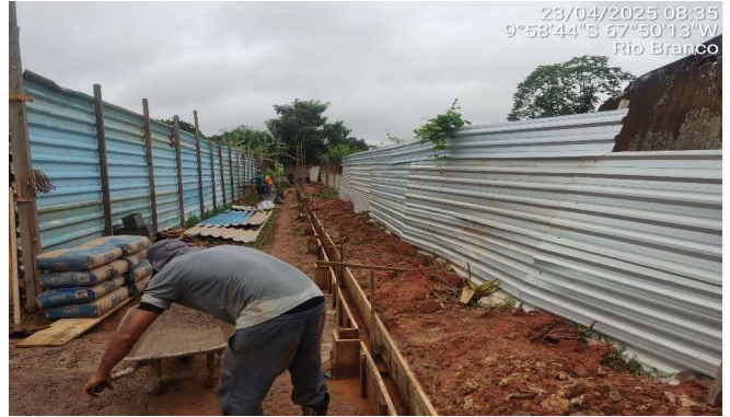
Imagem 26 Execução de viga baldrame
