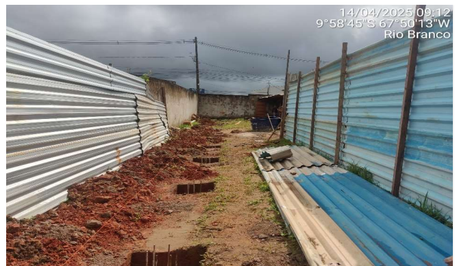
Imagem 12 Execução de blocos de concreto
