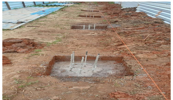
Imagem 4 Execução das brocas de concreto
