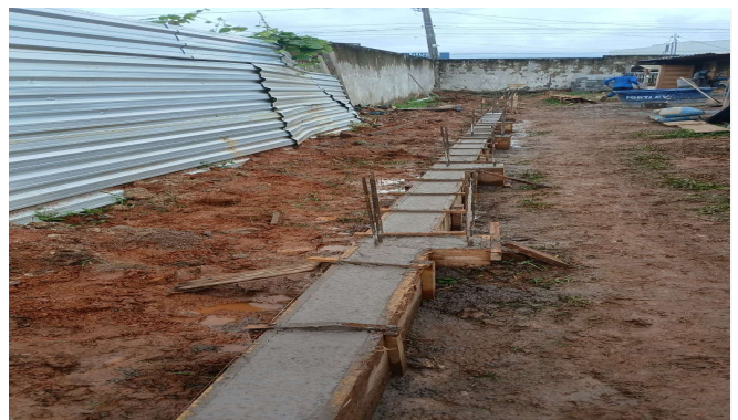
Imagem 30 Execução de viga baldrame
