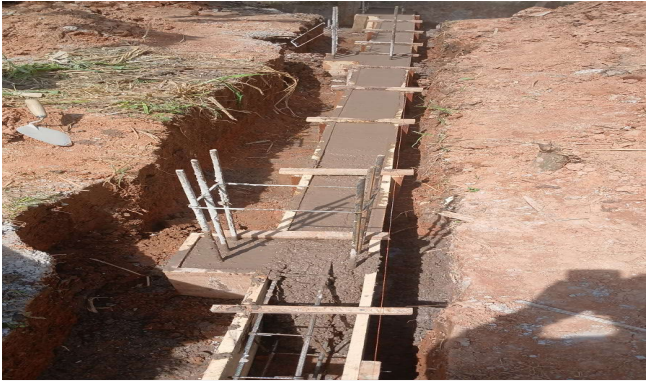
Imagem 25 Execução de viga baldrame
