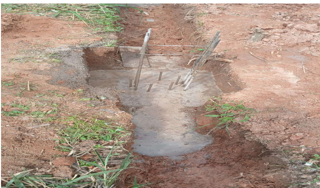
Imagem 17 Execução de blocos de concreto
