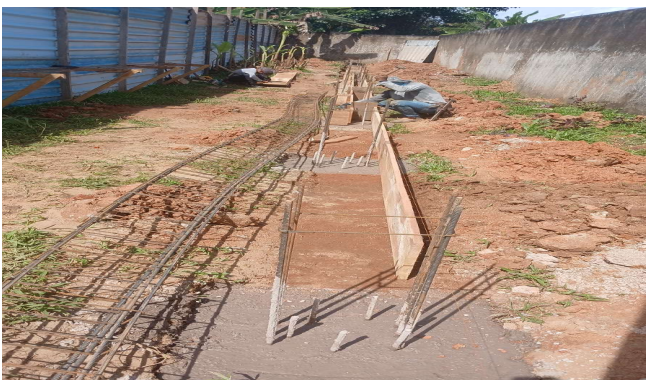
Imagem 23 Execução de viga baldrame
