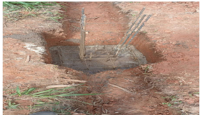
Imagem 16 Execução de blocos de concreto
