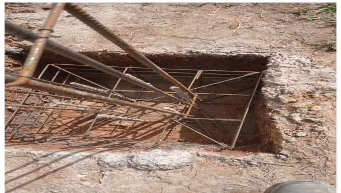
Imagem 22 Execução de blocos de concreto
