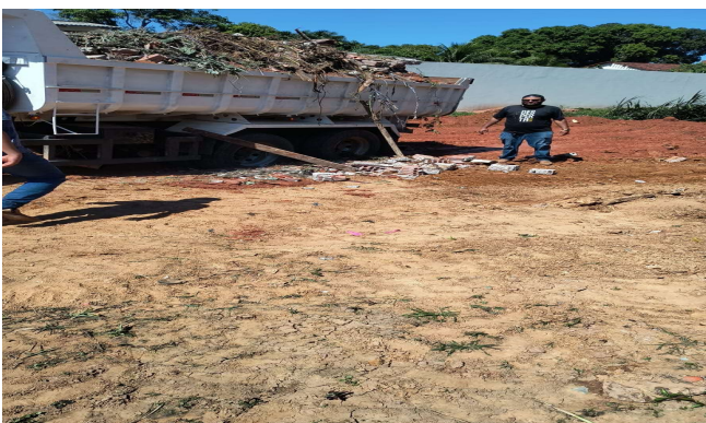
Imagem 11 Demolição, carga e transporte do muro antigo
