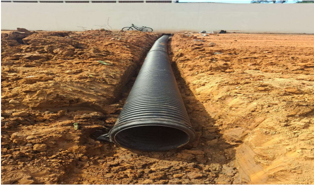
Imagem 19 Instalação de tubo pead 400mm
