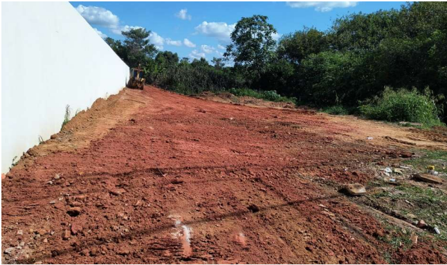
Imagem 25 Execução de aterro no terreno ao fundo da unidade
