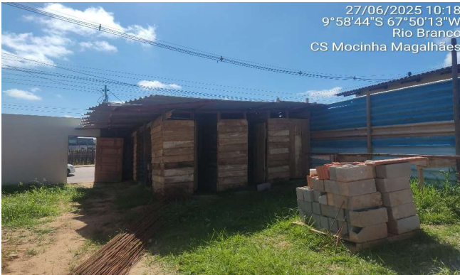
Imagem 7 Canteiro de obras
