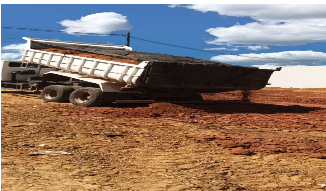
Imagem 23 Execução de aterro no terreno ao fundo da unidade
