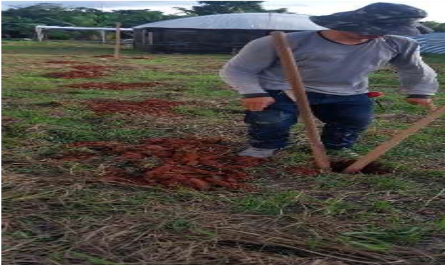
Imagem 1 Execução de tapume
