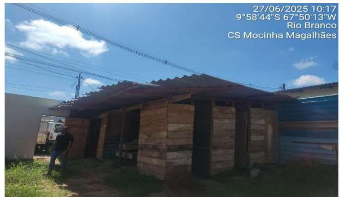
Imagem 6 Canteiro de obras
