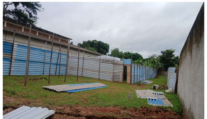
Imagem 4 Execução de tapume
