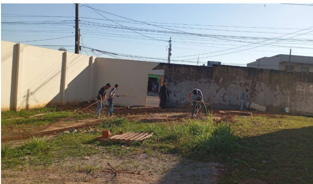
Imagem 29 Limpeza final de obra
