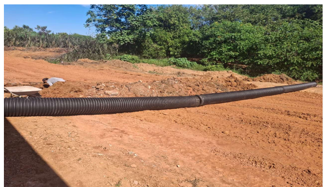
Imagem 18 Instalação de tubo pead 400mm
