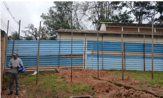
Imagem 3 Execução de tapume
