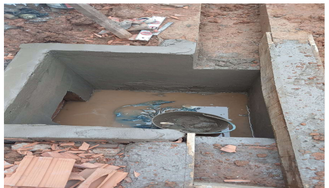
Imagem 16 Execução de caixa de passagem da canaleta
