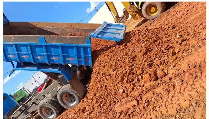
Imagem 22 Execução de aterro no terreno ao fundo da unidade
