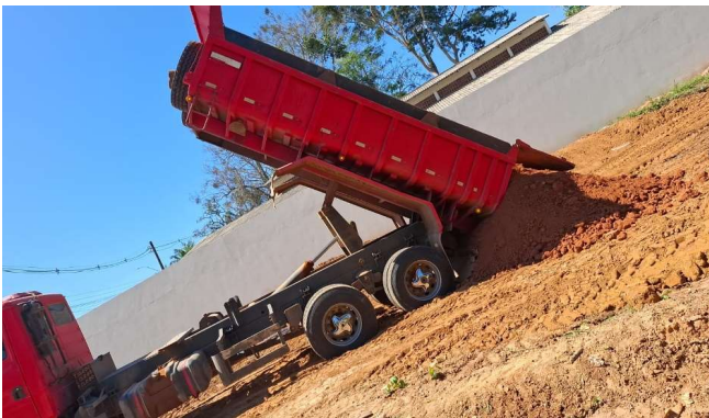
Imagem 21 Execução de aterro no terreno ao fundo da unidade
