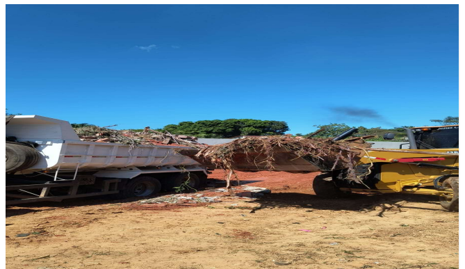
Imagem 10 Demolição, carga e transporte do muro antigo
