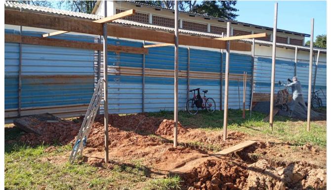
Imagem 2 Execução de tapume
