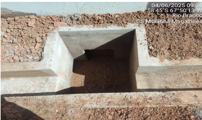
Imagem 15 Execução de caixa de passagem da canaleta
