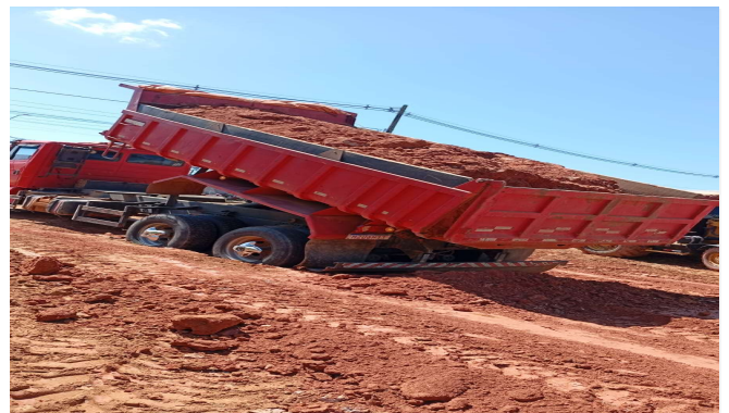
Imagem 24 Execução de aterro no terreno ao fundo da unidade
