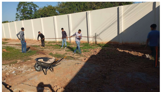
Imagem 30 Limpeza final de obra
