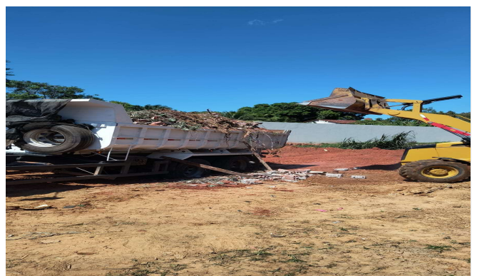
Imagem 12 Demolição, carga e transporte do muro antigo
