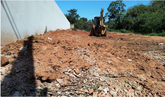
Imagem 13 Demolição, carga e transporte do muro antigo
