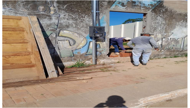
Imagem 14 Fechamento com alvenaria da porta de acesso a obra
