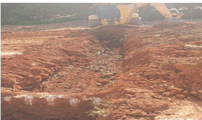
Imagem 17 Instalação de tubo pead 400mm
